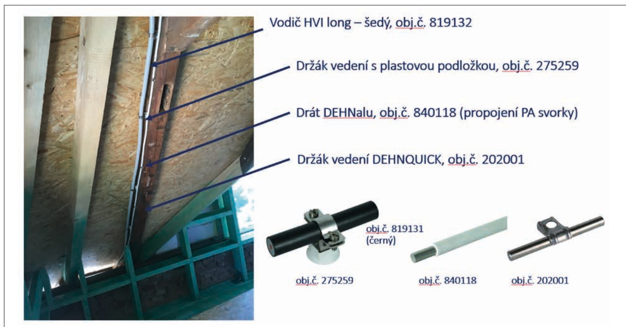
Obr. 5. Kotvení vodiče HVI long pod střešní krytinou
