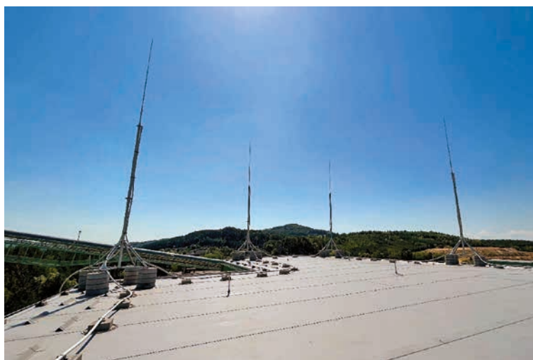
Obr. 10. Provedení jímací soustavy
