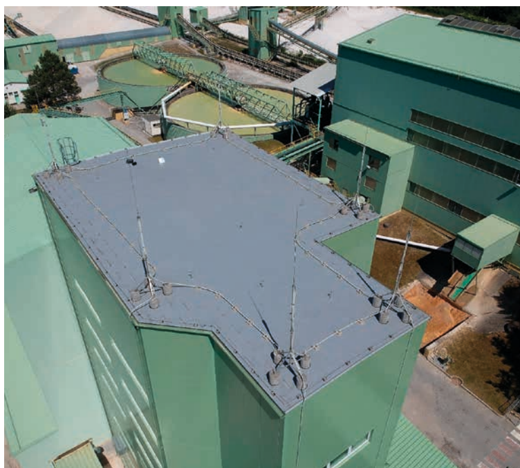
Obr. 9. Provedení jímací soustavy
