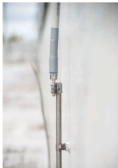
Obr. 8. Provedení připojení na zemnicí soustavu
