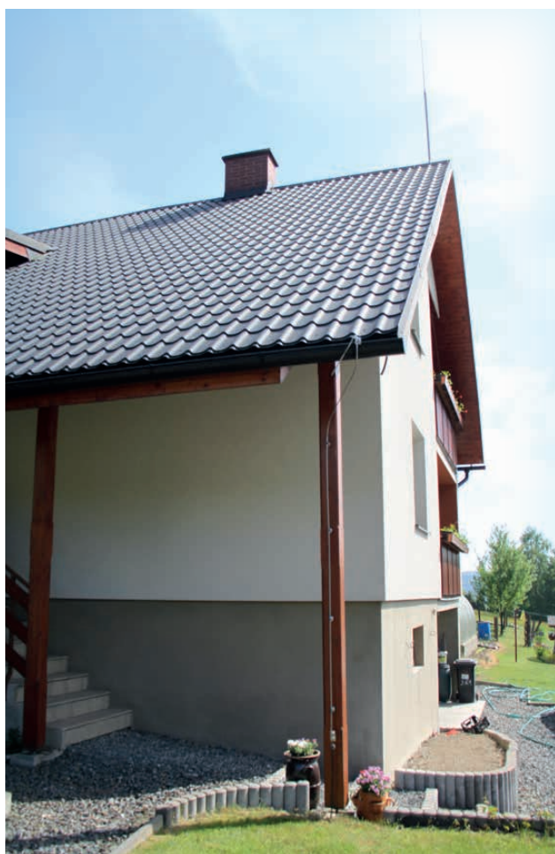
Obr. 8 Provedení hromosvodu na rodinném domě pomocí vodičů HVI long
