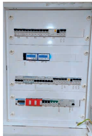
Obrázek 7 – Instalace přepětových ochran DEHNventil
