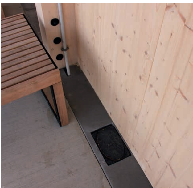
Obrázek 7 – Detail ukončení HVI vodiče v litinové zemi krabici
