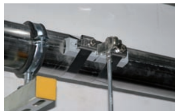
obr. 5 Připojení nerezové trubky pomocí páskové objímky do prostředí Ex.
