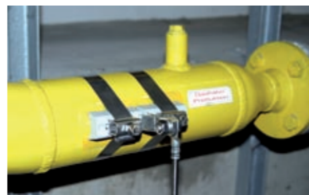
obr. 4 Pásková objímka slouží ke zřízení spolehlivého elektrického propojení potrubí se soustavou pospojování v prostředí Ex, viz DIN EN 62305-3 (ČSN EN 62305-3).
