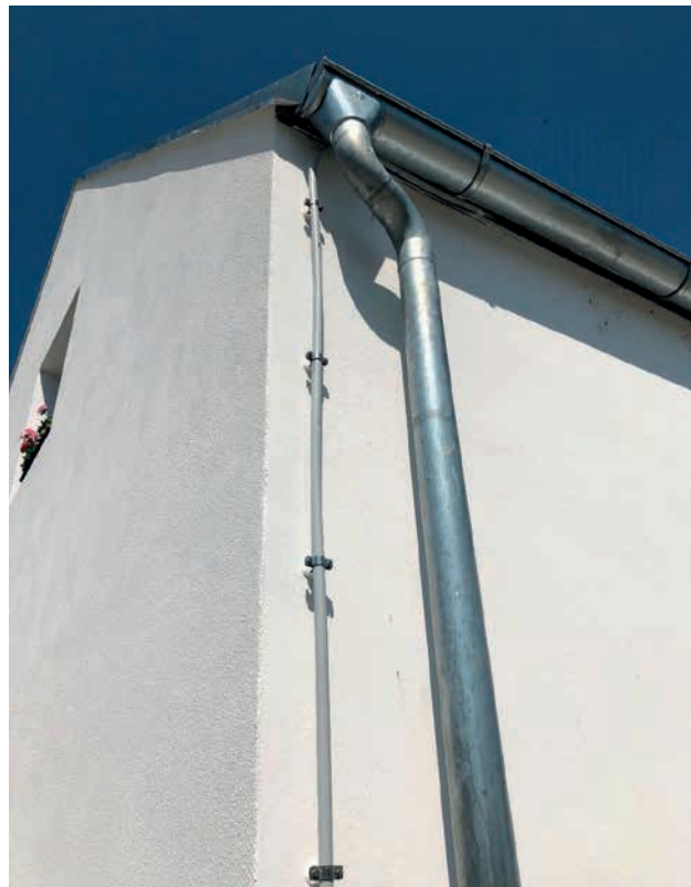
Detail svodu vedeného po fasádě
