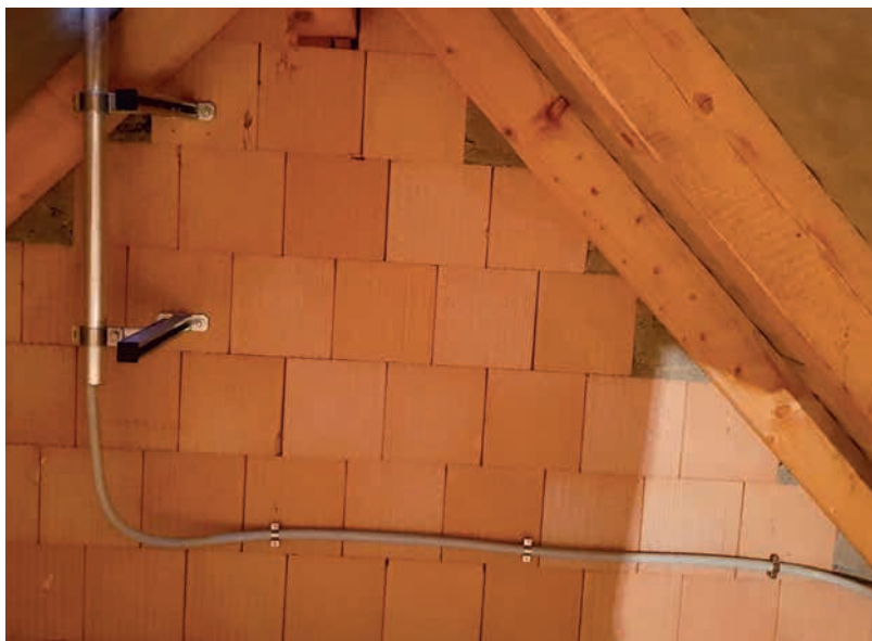
Detail kotvení podpůrné trubky ke štítu stavby
