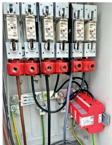
Zapojení DEHNventilu v neměřené části
