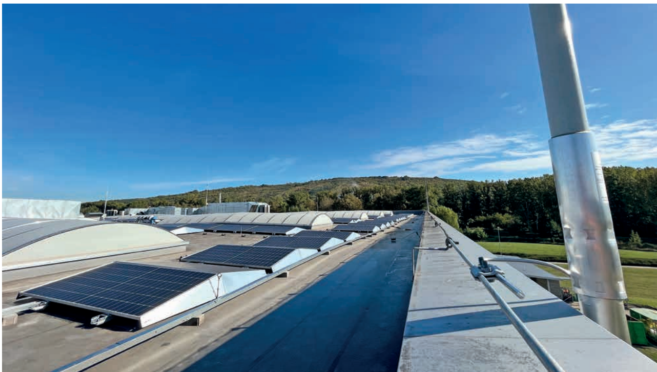
Provedení pospojování s využitím původního okružního vedení
