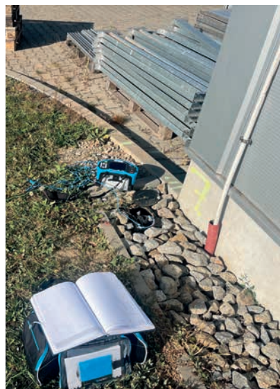
Přechod HVI vodiče do krabice se zkušební svorkou
