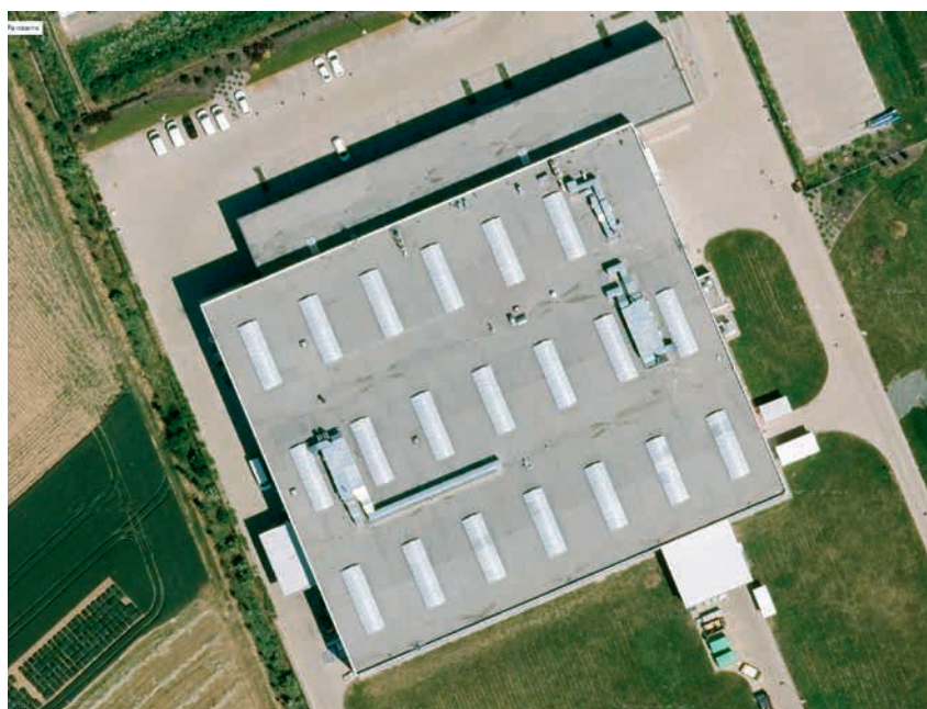
Pohled na střechu budovy před instalací FVE
