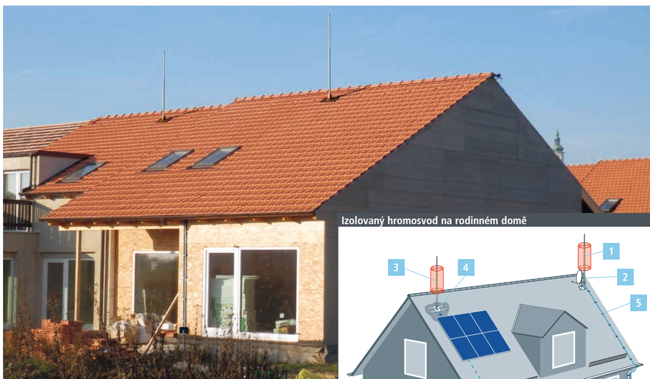
Obr. 11 Izolovaný hromosvod na rodinném domě
