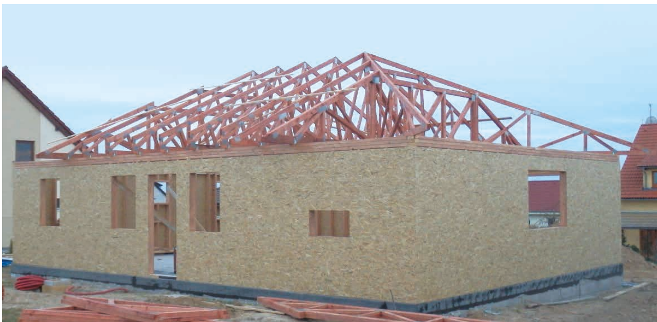
Obr. 5 Výstavba rodinného domu z dřevěné konstrukce
