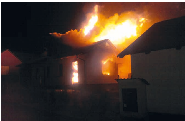
Obr. 3 Hořící dřevostavba, která ohrožuje i sousední stavby
