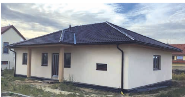
Obr. 7 Dokončena výstavba rodinného domu - dřevostavby
