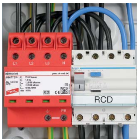
Zapojení do V prostřednictvím přípojovacích svorek s kolíkem STAK 25.
