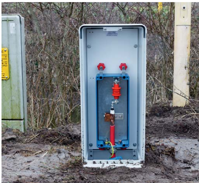
Koaxiální připojení jiskřiště pro Ex-zóny k ochraně podzemních izolačních členů
