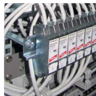
Montážní sada (lišta, distanční sloupky) jako příslušenství pro 19" rozvaděč.
