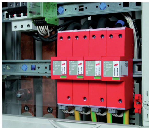
Obr. 2. Svodič DEHNvenCI s integrovaným předjištěním
