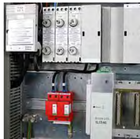
Umístění svodičů DEHNsecure
