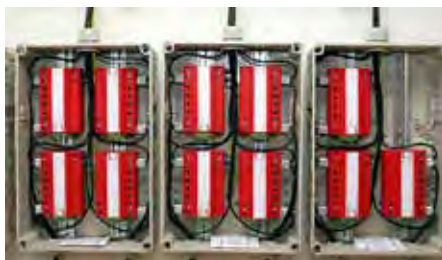
Příklad použití DEHNlimit PV 10000 pro ochranu měniče
