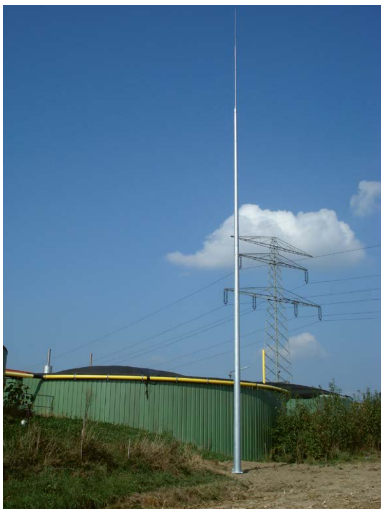
Obrázek 2 Bioplynová stanice s teleskopickým jímacím stožárem
