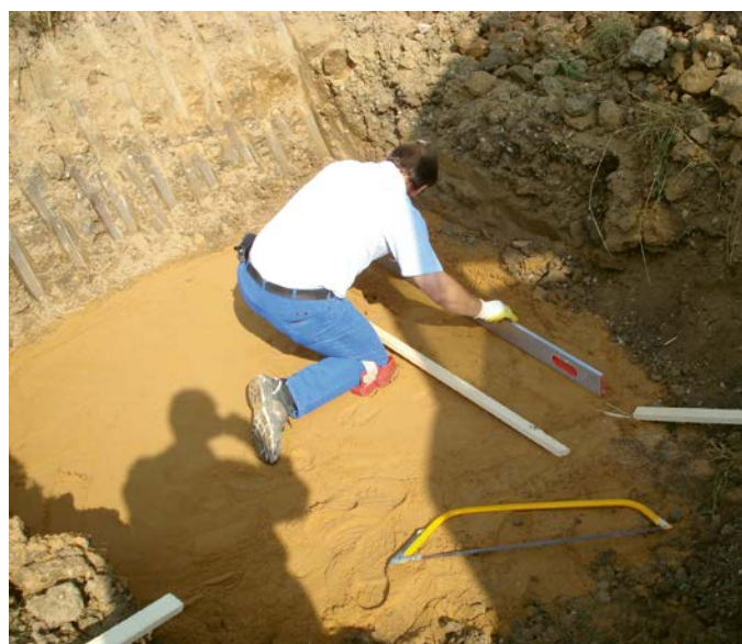
Obrázek 3a Základová jáma s pískovým ložem
