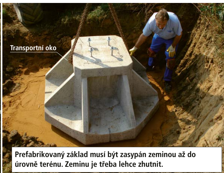
Obrázek 3b Prefabrikovaný základ KöFU I
