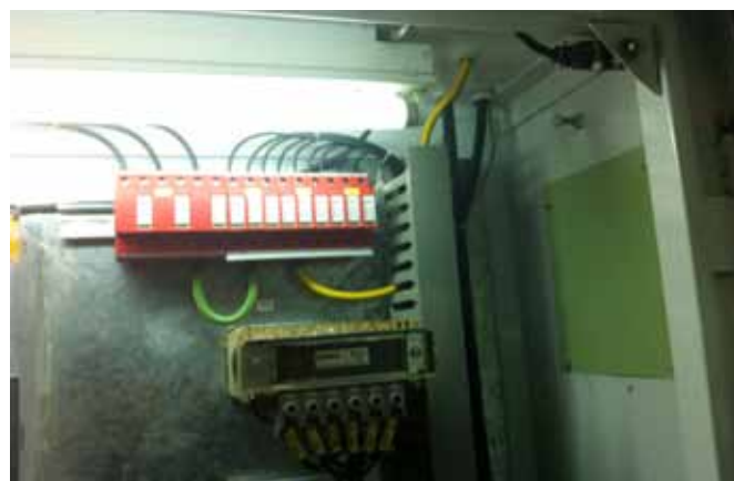
Obr. 6 DEHNventil chrání frekvenční měnič
