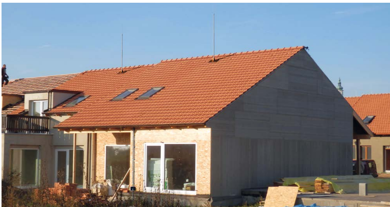
Obr. 11 Izolovaný hromosvod na rodinném domě
