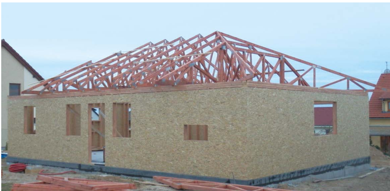
Obr. 5 Výstavba rodinného domu z dřevěné konstrukce
