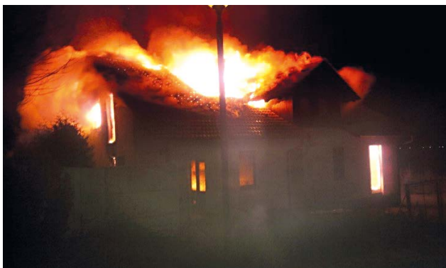
Obr. 4 Rychlé šíření požáru rodinného domu, které je dáno jeho konstrukcí i větrem
