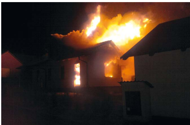
Obr. 3 Hořící dřevostavba, která ohrožuje i sousední stavby
