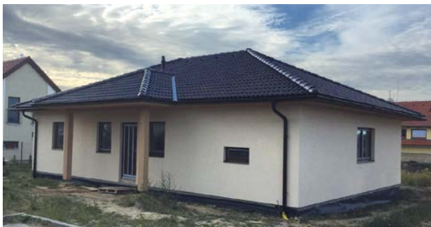
Obr. 7 Dokončena výstavba rodinného domu - dřevostavby
