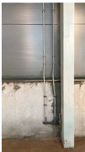
Připojení paralelních svodů k uzemnění
