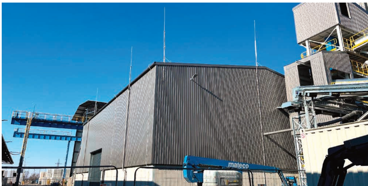
Pohled na část z budov s jímací soustavou
