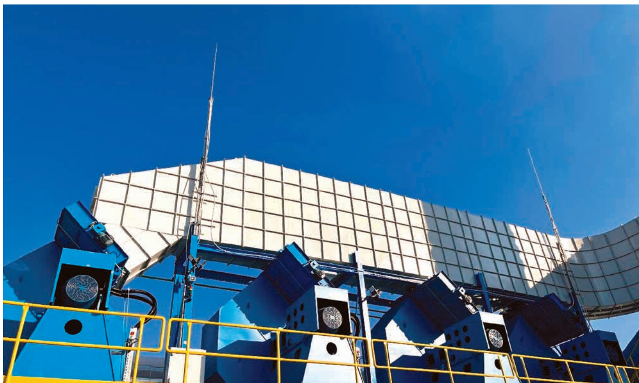
Umístění podpurných trubek na technologii výrobního závodu
