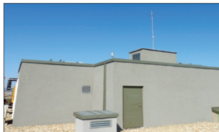
Obr. 2. Jímáč ESE na střeše multifunkčního objektu
