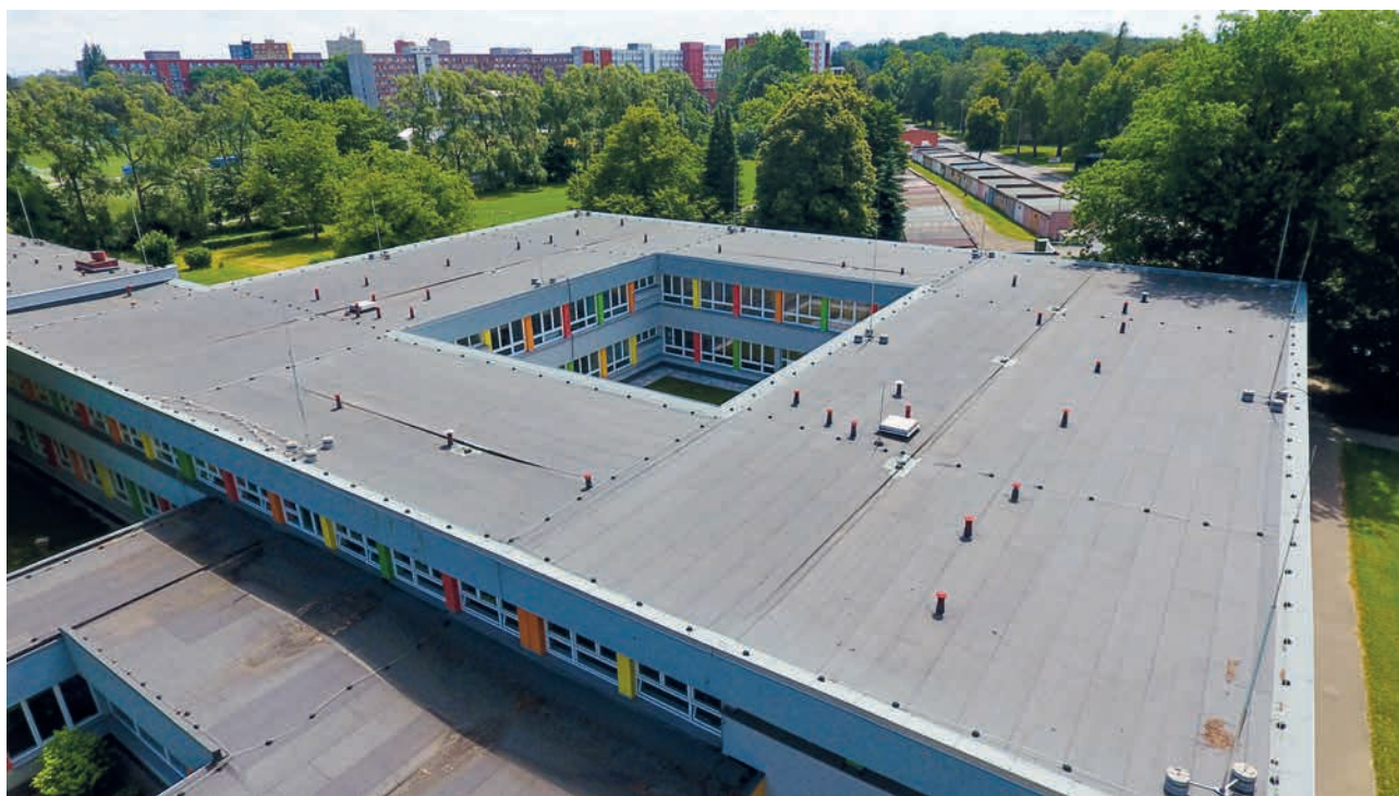
Obrázek 3 – Celkový pohled na instalaci vodiče HVI power
