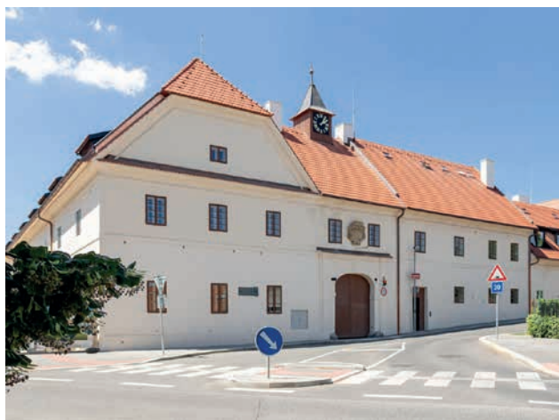
Obr. 5. Jínonický dvůr po rekonstrukci
