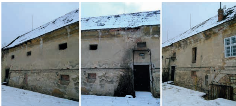
Obr. 3. Objekt před rekonstrukcí
