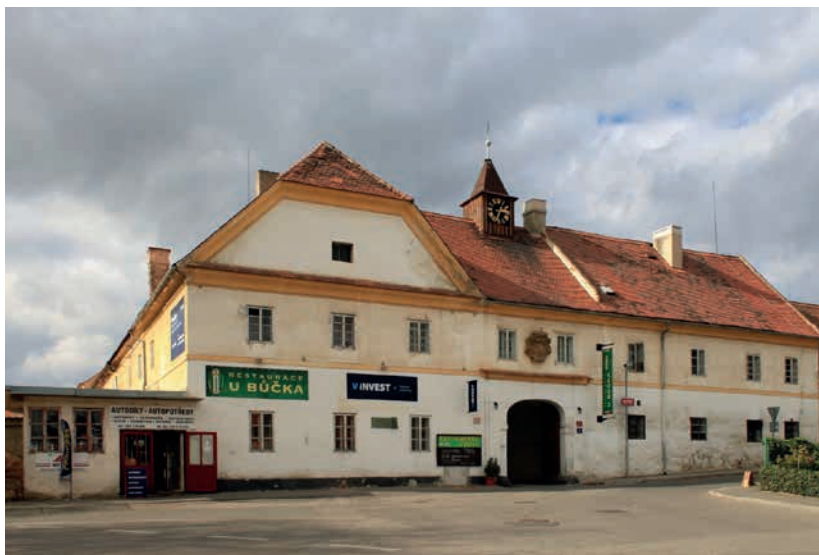
Obr. 1. Objekt před rekonstrukcí
