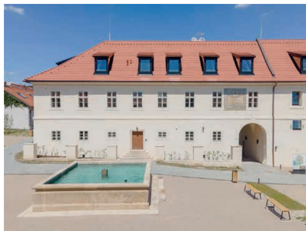
Obr. 6. Jínonický dvůr po rekonstrukci
