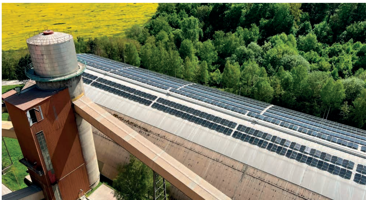
Celkový pohled na FVE
