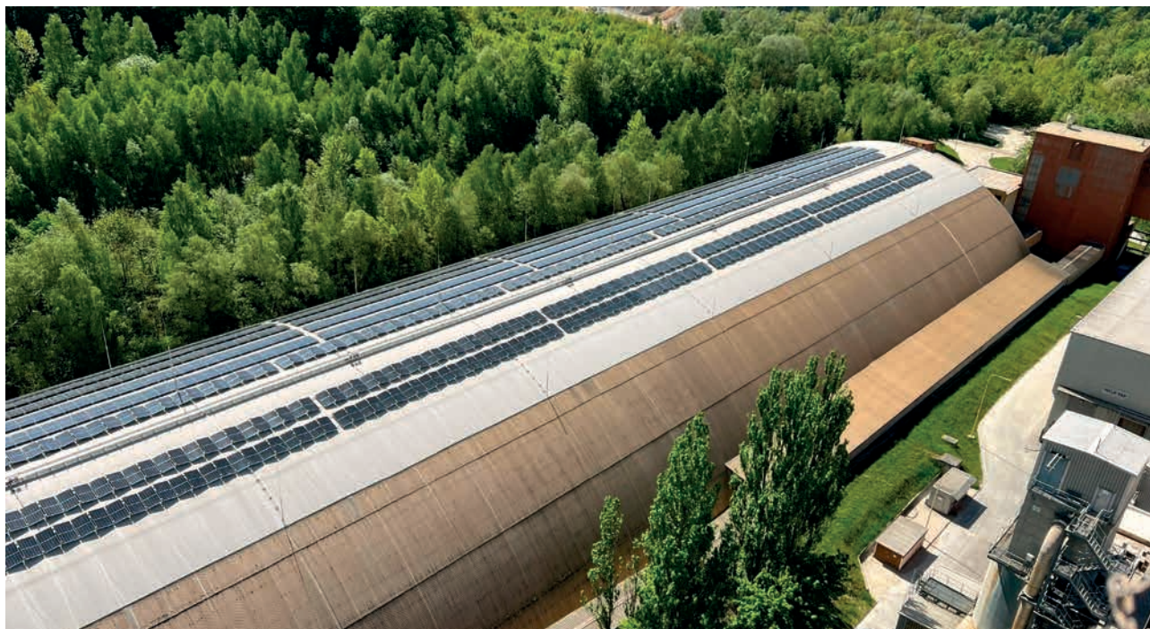
Celkový pohled na FVE
