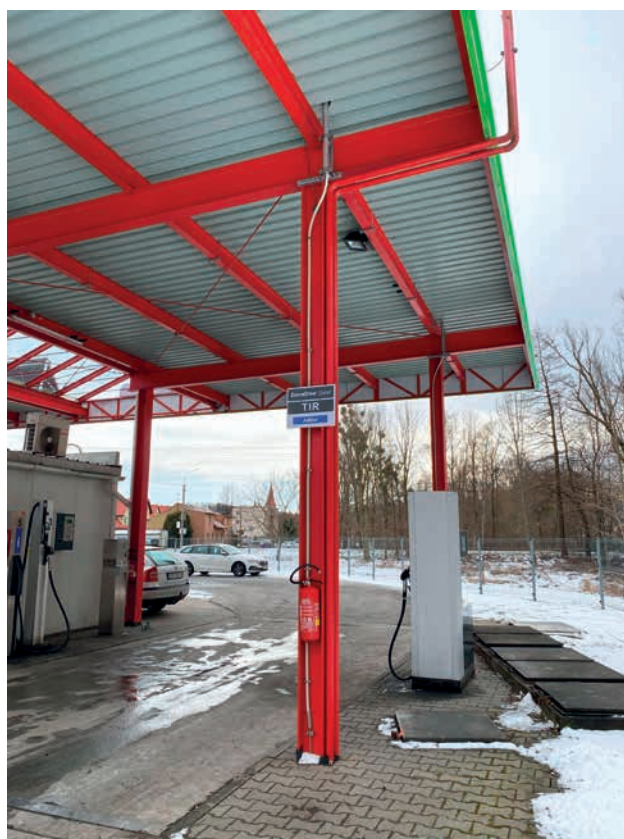
Vedení svodu po nosném pilíři s napojením na zkušební svorku
