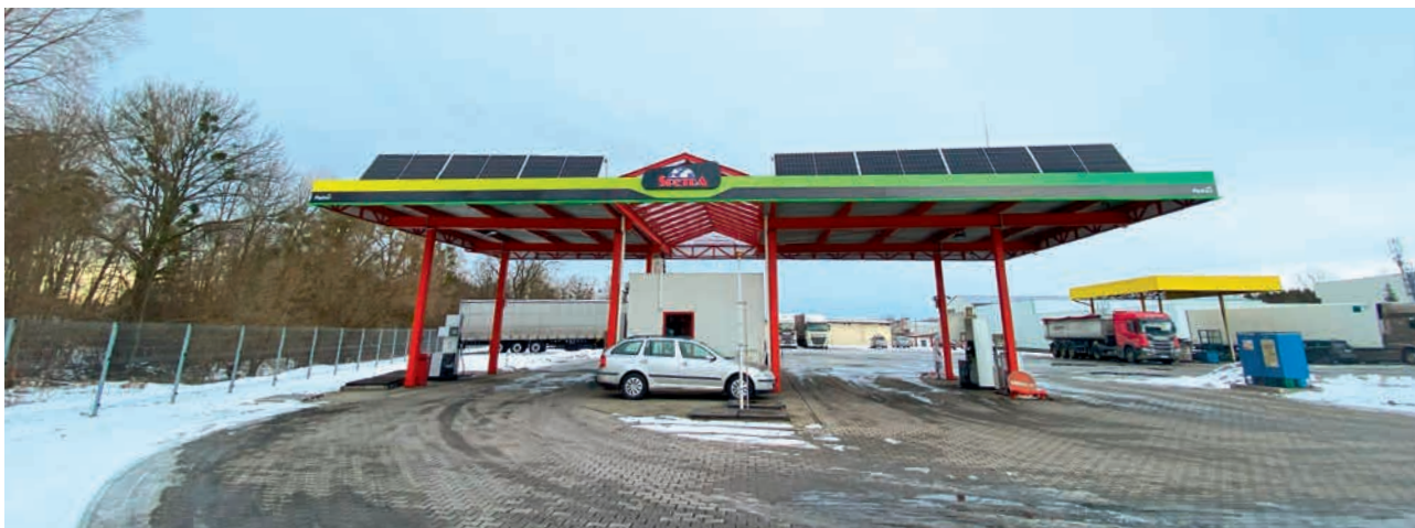
Celkový pohled na čerpací stanici
