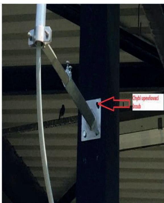
Ukázka chybného kotvení podpůrné trubky: chybí šroub = snížená stabilita
