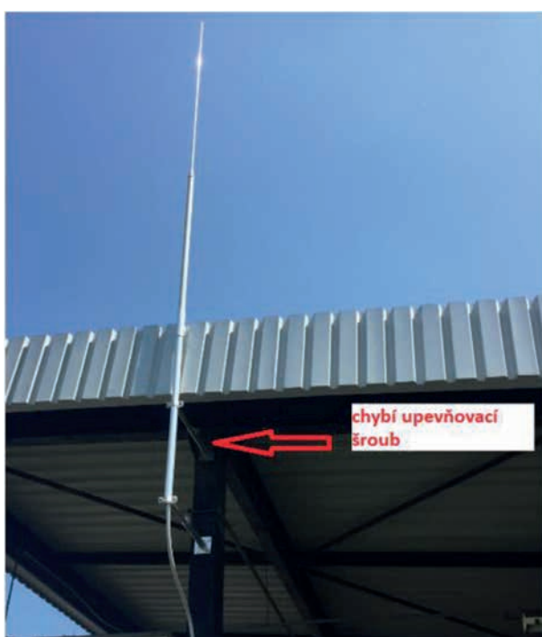
Ukázka chybného kotvení podpůrné trubky: chybí šroub = snížená stabilita
