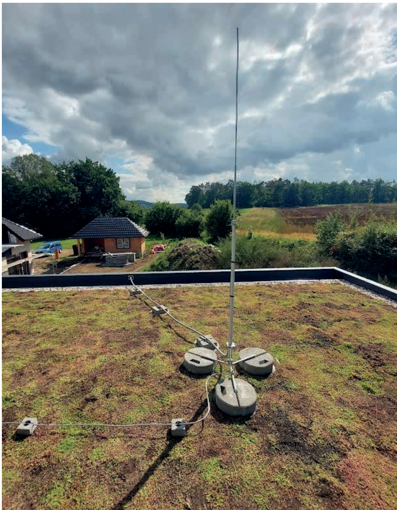
Obr. 3. Osazení podpůrné trubky s jímací tyčí na zelené střeše objektu
