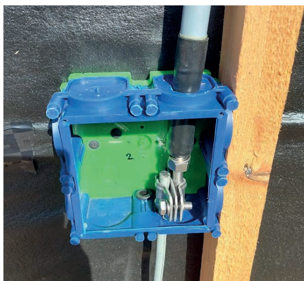
Obr. 5. Svod HVI vodičem do krabice se zkušební svorkou
