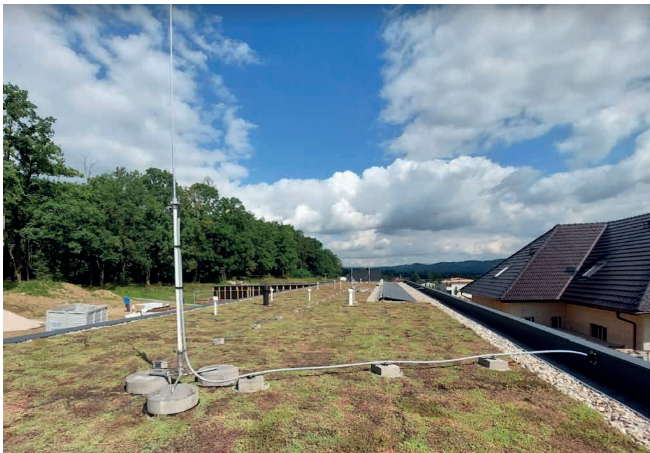
Obr. 4. Provedení objektu s jímací soustavou
