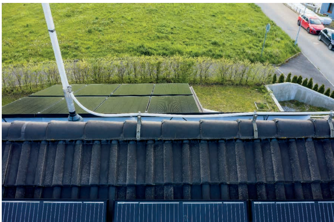
Obrázek 5 – Detail jimače a vedení po hřebenu
