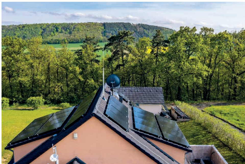
Obrázek 3 – Pohled na střechu RD
