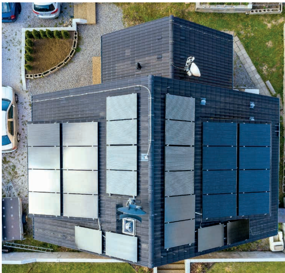
Obrázek 4 – Celkový pohled na střechu RD
