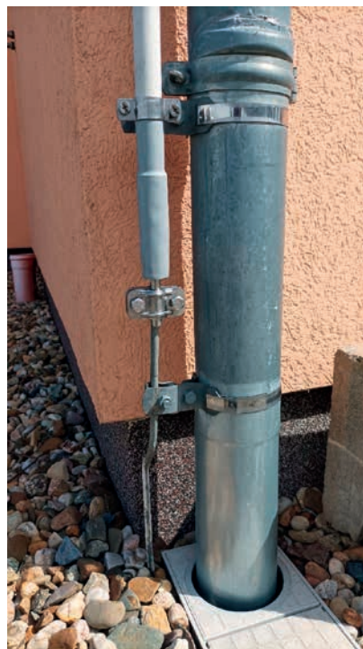
Obrázek 7 – Detail napojení svodu na uzemnění
