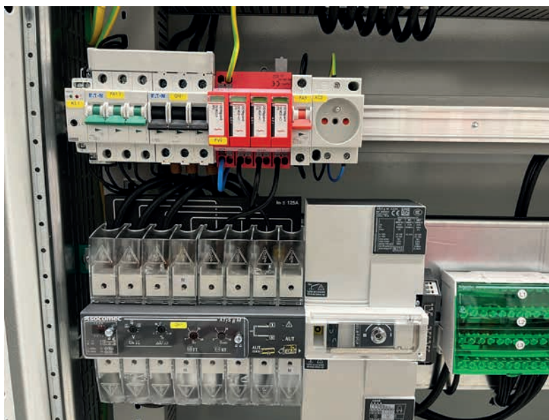
Detail zapojení SPD náhradního zdroje (UPS)
