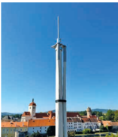
Obr. 7. Napojení vodiče HVI na podpůrnou trubku
