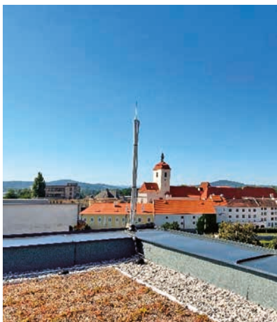
Obr. 5. Osazení podpůrné trubky
