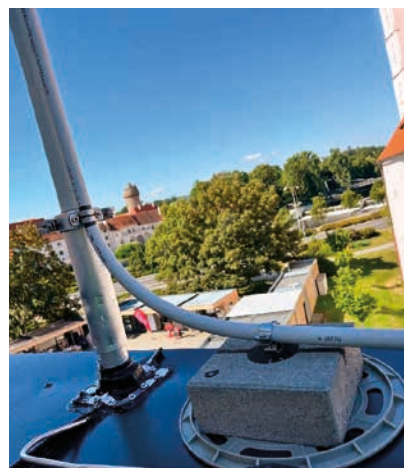
Obr. 6. Detail prostupu podpůrné trubky
