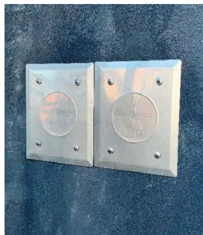
Obr. 8. Detail krabice pro zkušební svorku do zateplení
