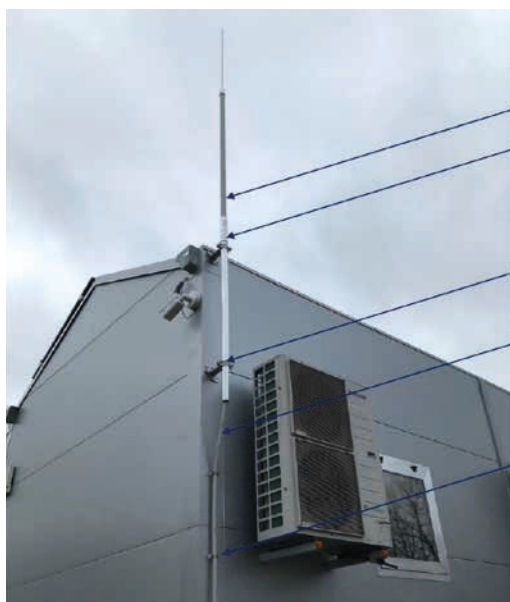
Obr. 6. Detail kotvení podpůrné trubky a vodiče HVI long
