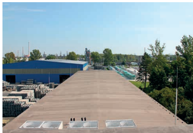
Pohled na halu vedle administrativní budovy
