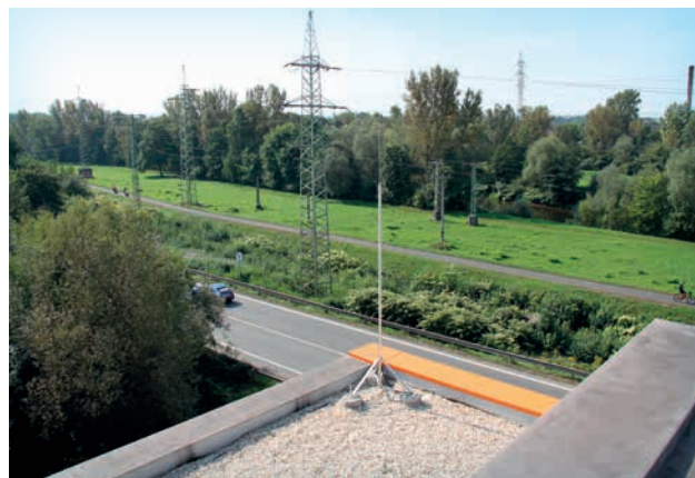
Detail jímače
