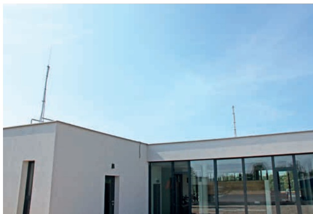
Jímače na střešní nástavbě
