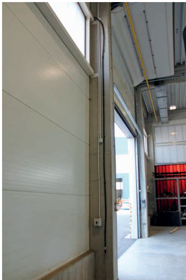
Detail svodu uvnitř haly
