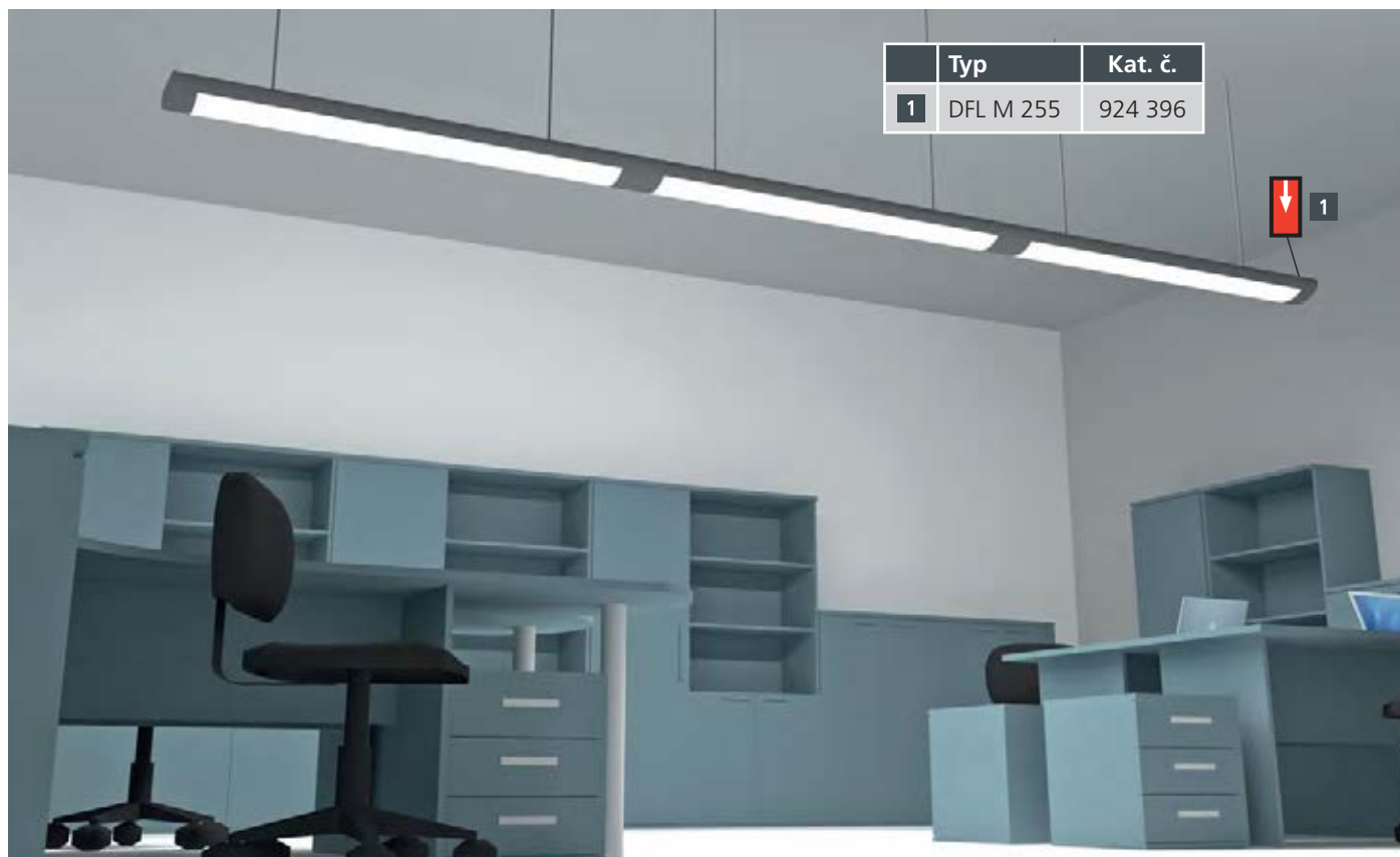
Obrázek 9.25.1 Svodič přepětí typu 3 v osvětlovacích tělesech kancelářských prostor
