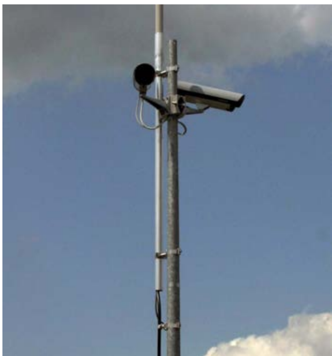
Obrázek 9.22.4 Vodič HVI instalovaný na stožáru
