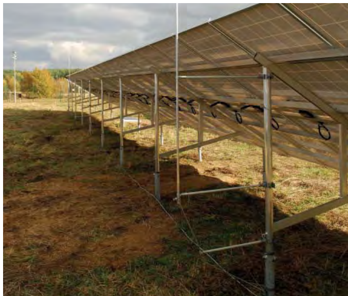
Obrázek 9.19.2 Hromosvod s držáky DEHNiso
