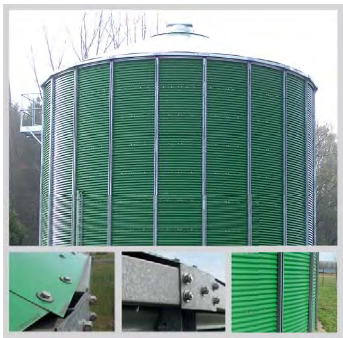
Obrázek 9.3.6 Kvasný tank ze sešroubovaných kovových tabulí
