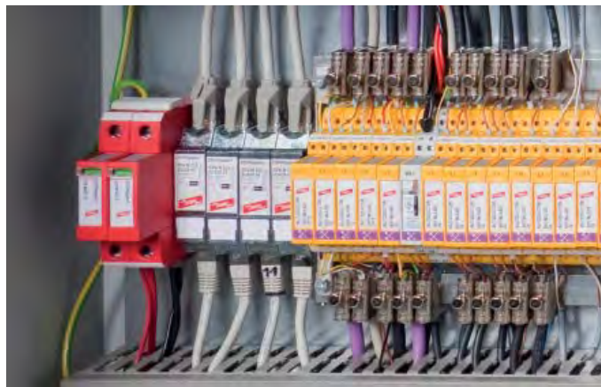
Obrázek 9.16.11 Příklad ochrany v pitch-systému
