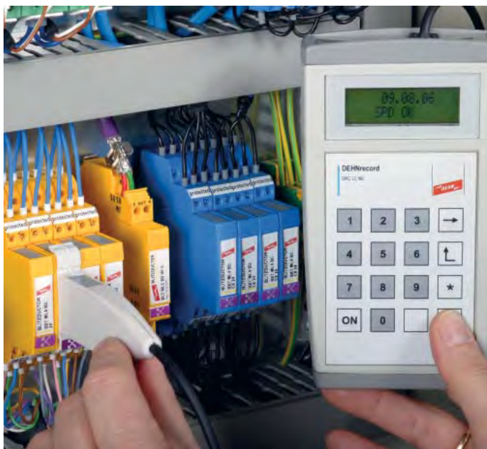
Obrázek 9.3.12 Moduly kombinovaných svodičů s technologií LifeCheck
