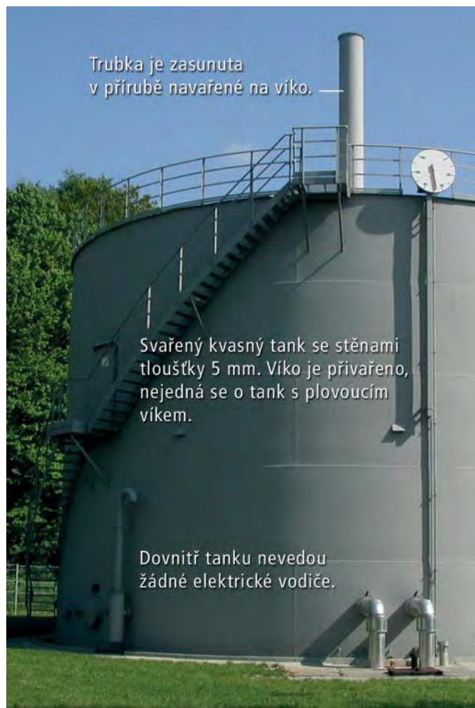
Obrázek 9.3.8 Svařený ocelový zásobník (zdroj: Eisenbau Heilbronn GmbH)
