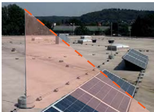
Obrázek 9.18.14 Stanovení ochranného prostoru metodou ochranného úhlu
