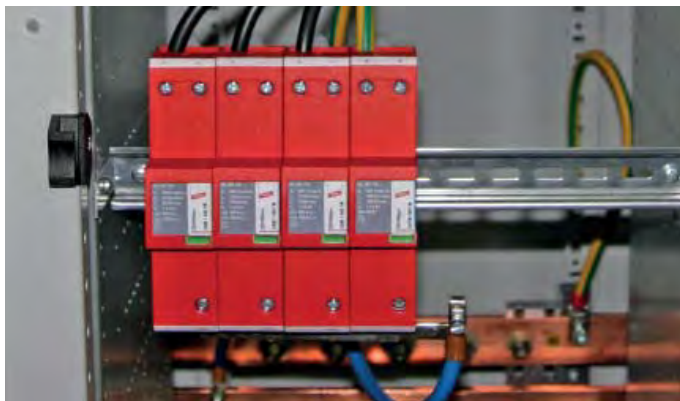
Obrázek 9.16.8 Koordinovaný svodič přepětí SPD typu 1
