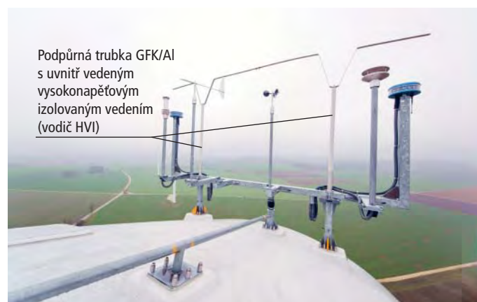
Obrázek 9.16.2 Příklad jímací soustavy pro meteorologickou stanici a pro výstražné letecké osvětlení
