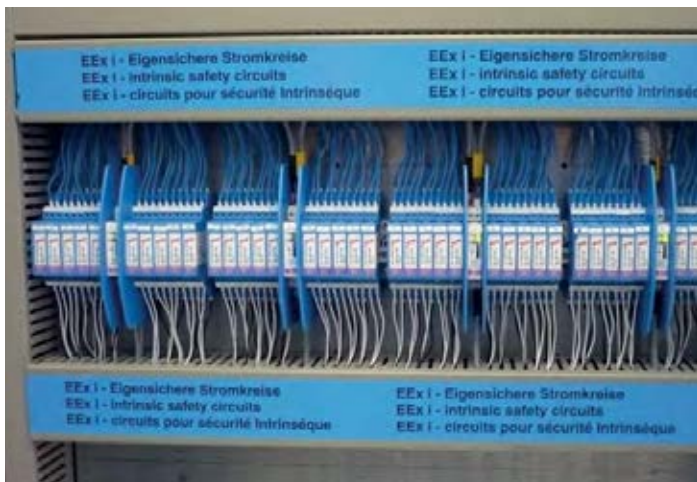
Obrázek 9.32.5 Přepětové ochrany pro jiskrově bezpečné měřicí obvody
