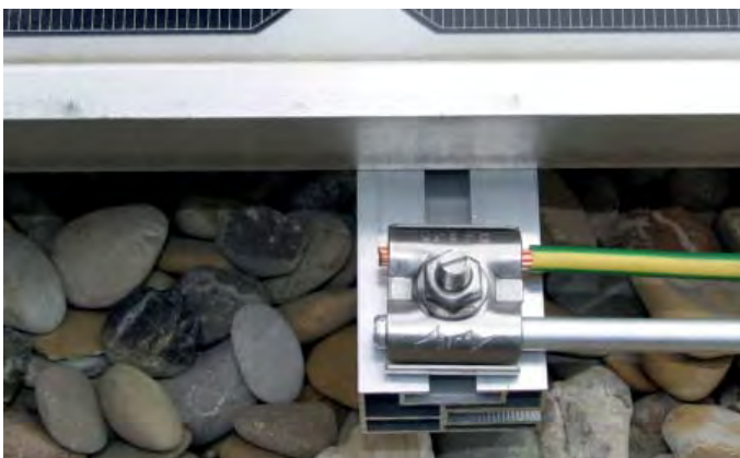
Obrázek 9.18.3 Zemničí svorka UNI: mezičlen z korozivzdorné oceli zabraňuje kontaktní korozi. Tím jsou vytvořena dlouholetá spolehlivá propojení mezi různými materiály vodičů.
