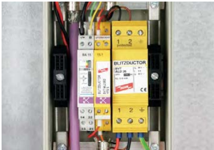
Obrázek 9.16.8 Koordinovaný svodič přepětí SPD typu 1
