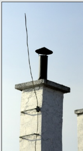
Zjednodušená představa oddáleného hromosvodu
