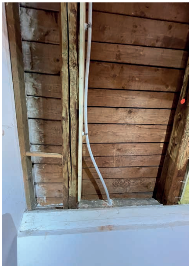
Obrázek 7 – Vedení vodiče HVI ve skladbě střechy
