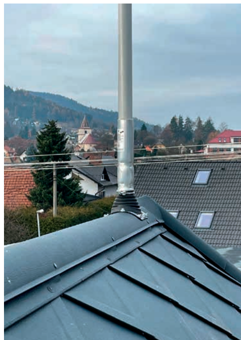
Obrázek 5 – Detail prostupu skrz střechu
