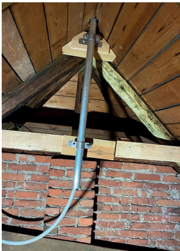
Obrázek 6 – Detail kotvení podpůrné trubky k trámův
