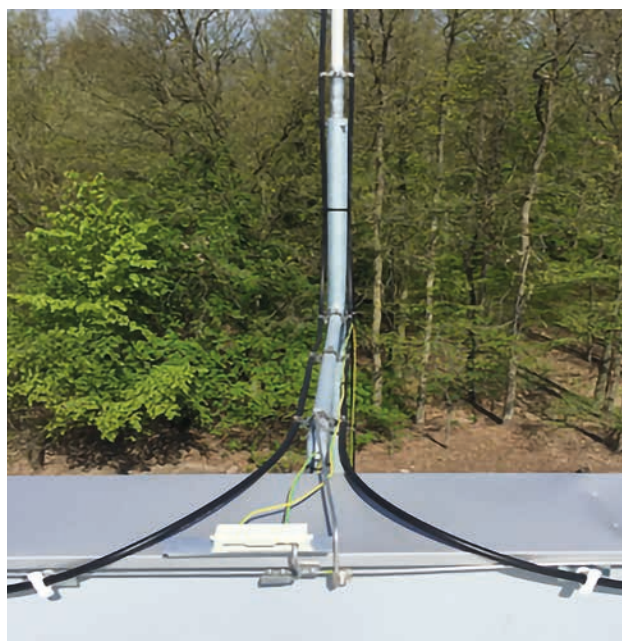
Obr. 7. Zasunutí jímače do svisle konstrukce
