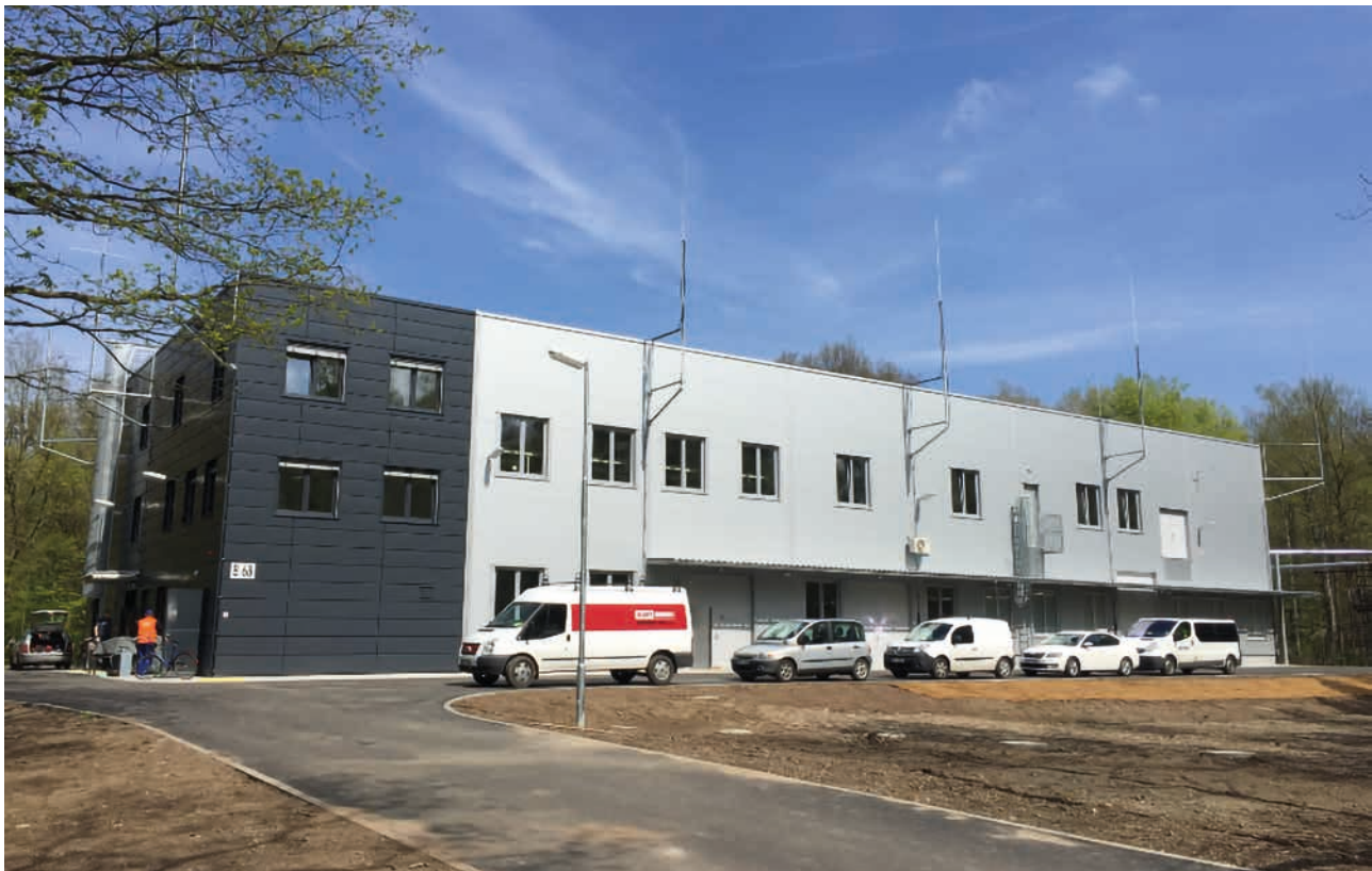
Obr. 5. Pohled na halu s ochranou před bleskem
