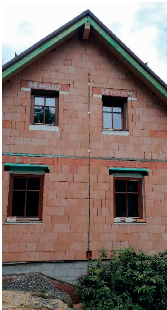
Obr. 5. Vedení HVI uložené ve zdivu
