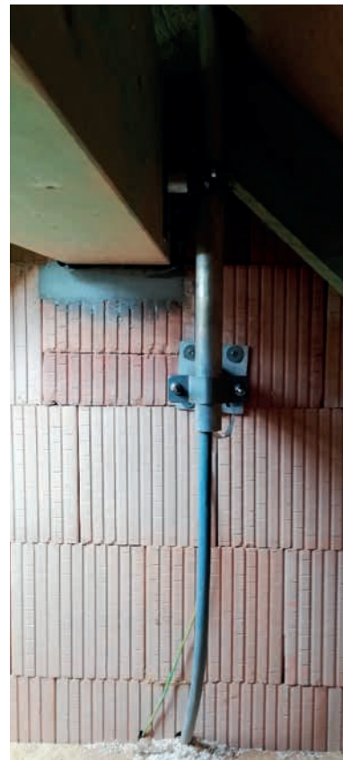
Obr. 2. Provedení kotvení podpůrné trubky
