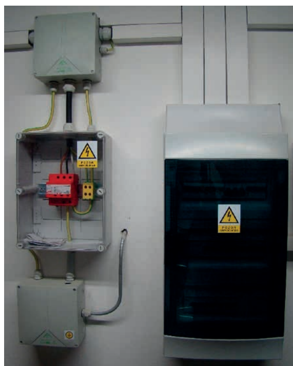
Obr. 9. Instalován typ T1 + T2, DEHNshield TNC u hlavní- ho rozvaděče objektu
