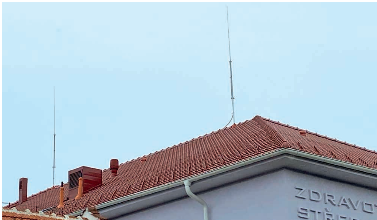
Obrázek 3 – Podpůrné trubky s jímačími tyčemi
