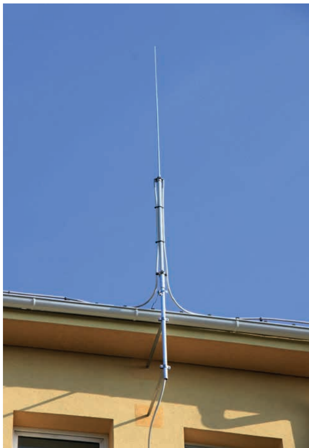
Obrázek 6 – Detail podpůrné trubky s jímačem
