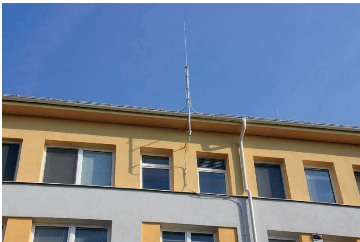
Obrázek 5 – Detail podpůrné trubky s jímačem
