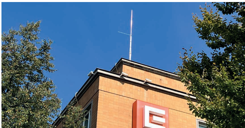
Stranový jímač k rozšíření ochranného prostoru
