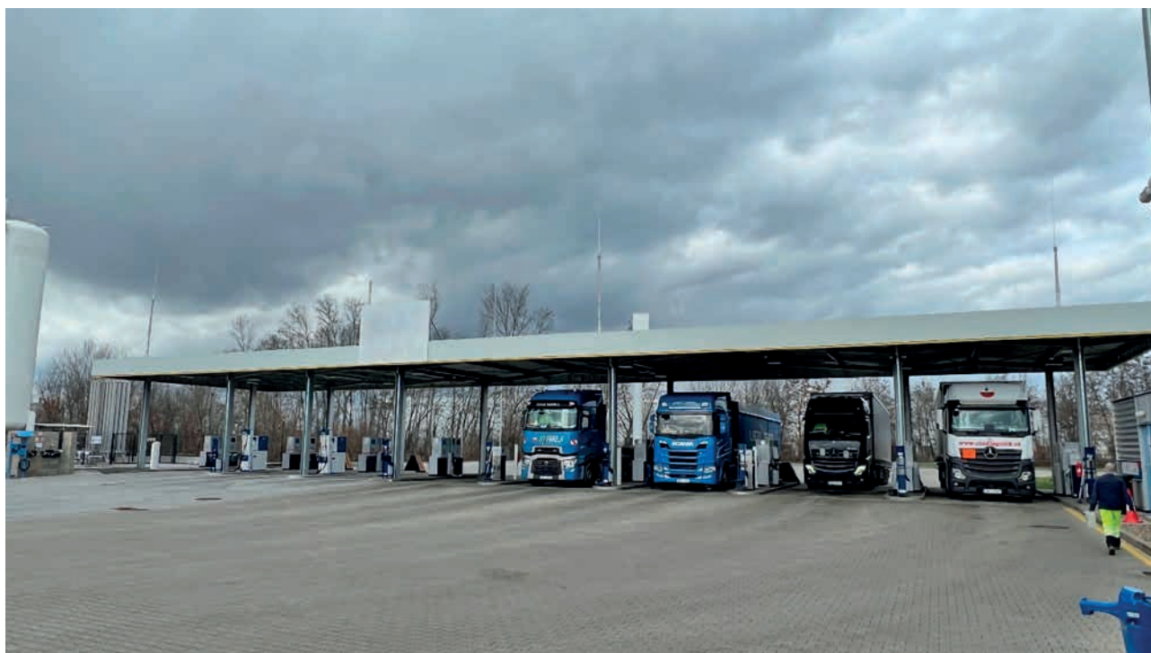
Obrázek 2 – Celkový pohled na čerpací stanici
