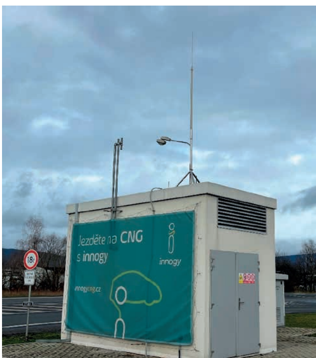
Obrázek 6 – Detail menšího objektu v areálu čerpací stanice
