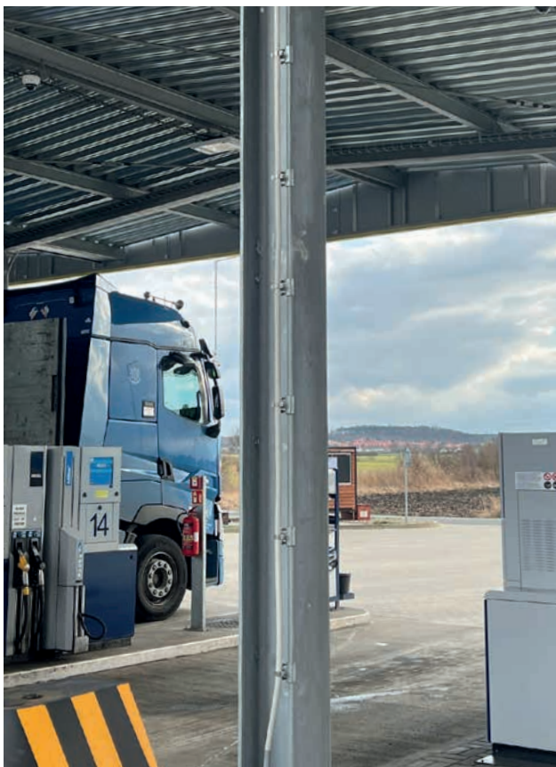
Obrázek 4 – Detail svodu HVI long
