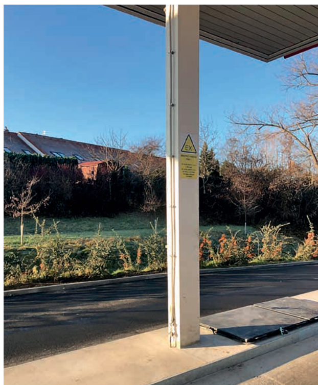
Obrázek 6b – Detail svodů
