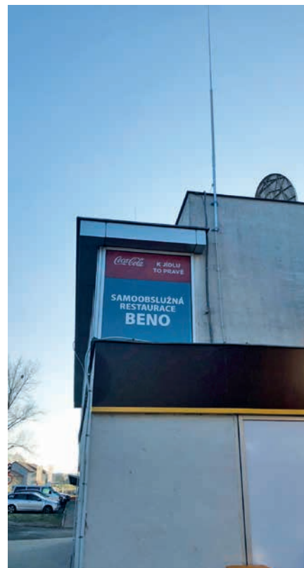
Obrázek 6a – Detail svodů
