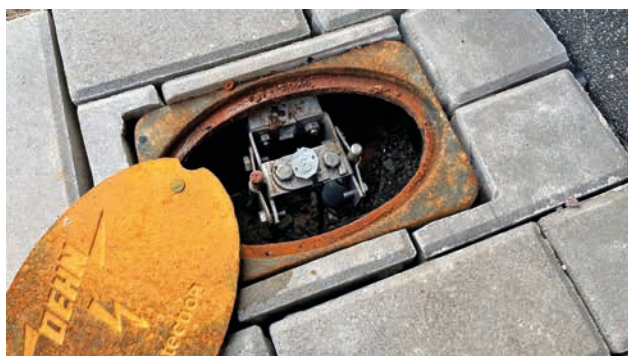
Obr. 4. Detail zemní litinové krabice
