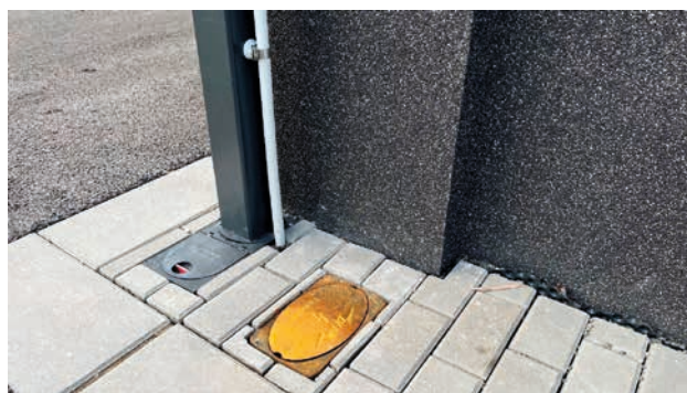
Obr. 5. Svod HVI vodičem do zemní litinové krabice
