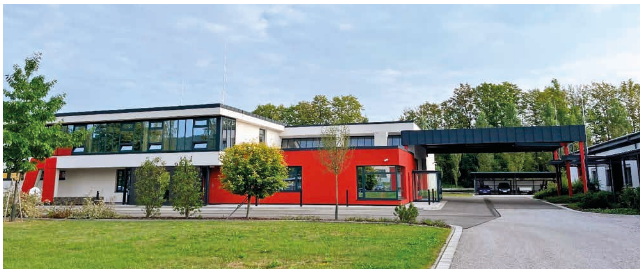
Obr. 6. Objekt s jímací soustavou
