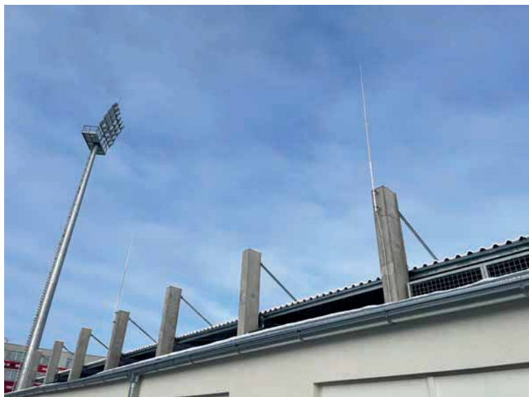
Obr. 7. Podpůrné trubky kotvené na sloupech
