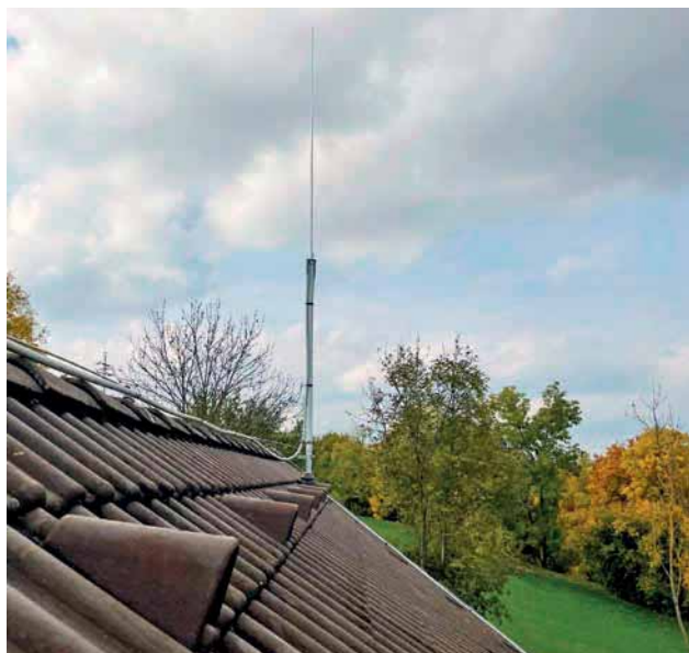
Obr. 5. Osazení podpůrné trubky s jímací tyčí na střeše objektu
