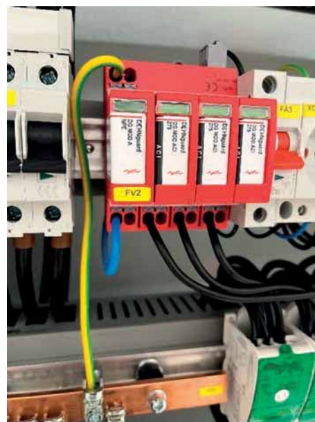
Detail zapojení SPD s využitím Push-in svorek
