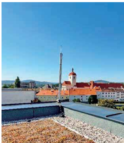
Obr. 5. Osazení podpůrné trubky
