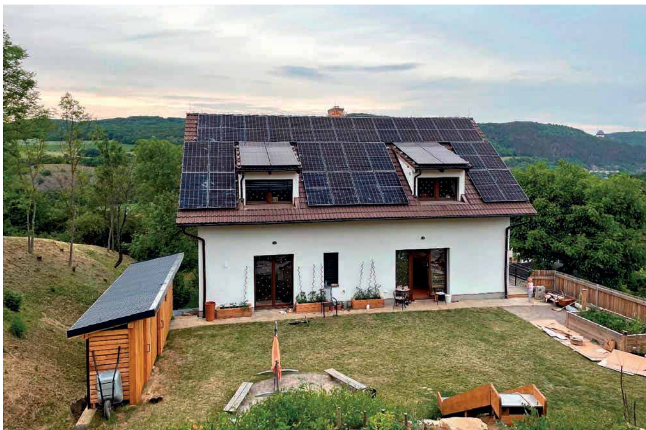
Obr. 1. Fotografie objektu s nevhovující jímací soustavou
