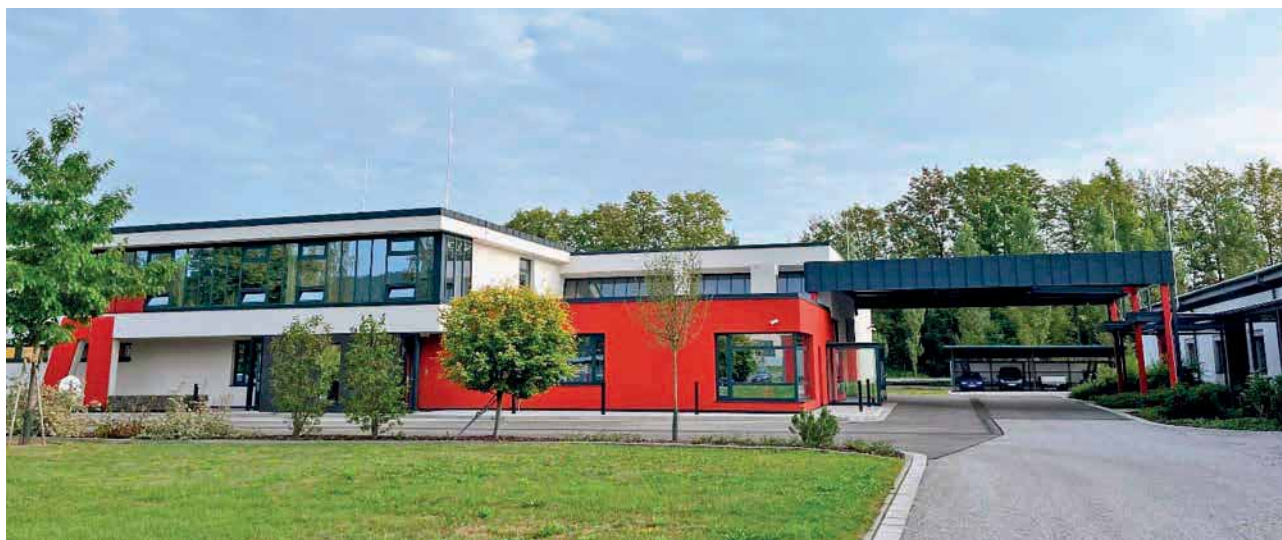
Obr. 6. Objekt s jímací soustavou
