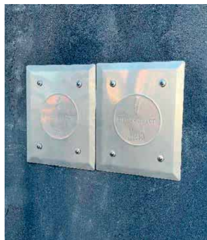
Obr. 8. Detail krabice pro zkušební svorku do zateplení
