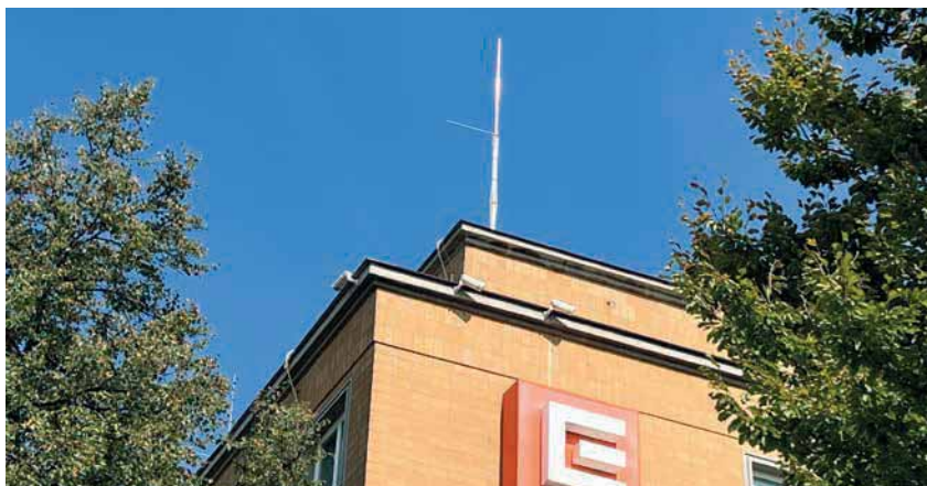
Stranový jímač k rozšíření ochranného prostoru
