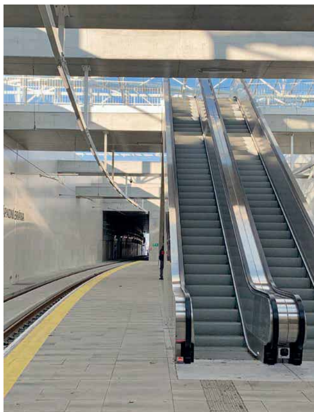
Obr. 2. Západní brána – tunel směr stanice Nemocnice Bohunice
