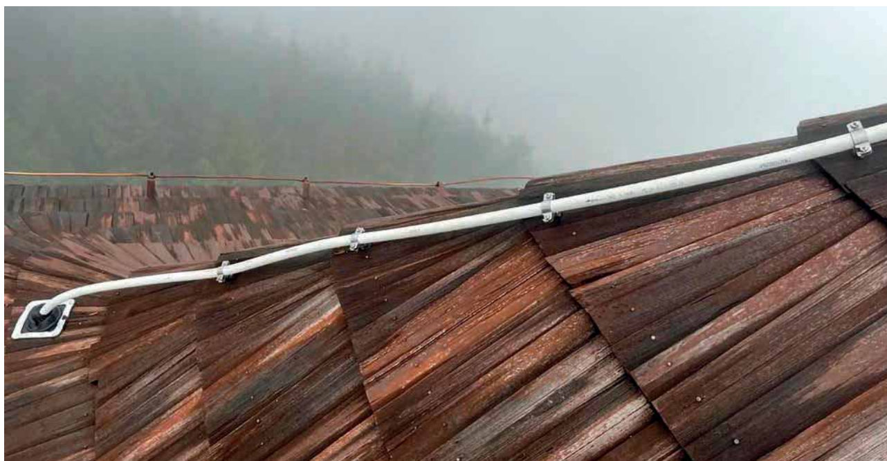
Obr. 5. Provedení svodu vodičem HVI long
