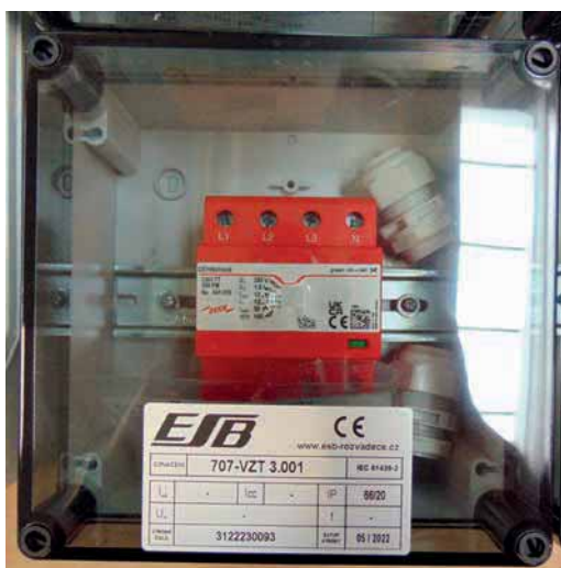
Obr. 6.-7. Rozvodnice s kombinovaným svodičem přepětí DEHNshild TT 255 FM před dodáním na stavbu
