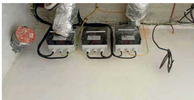
Obr. 9. Osazené rozvodnice pro technologická zařízení na střeše
