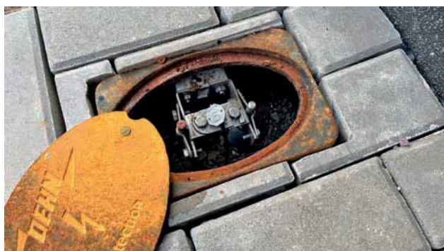
Obr. 4. Detail zemní litinové krabice
