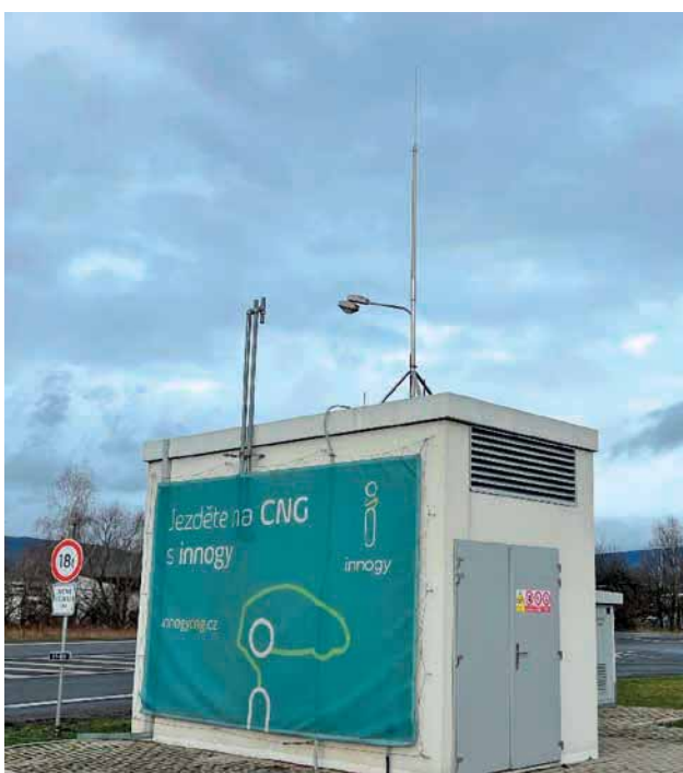
Obrázek 6 – Detail menšího objektu v areálu čerpací stanice
