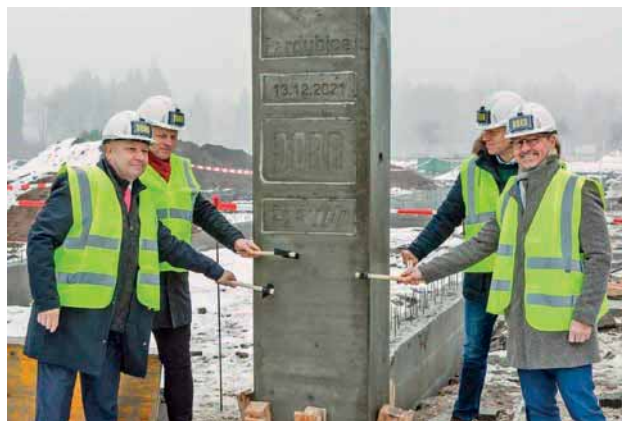
Obr. 1. Zapuštění sloupu do připraveného kalichu
