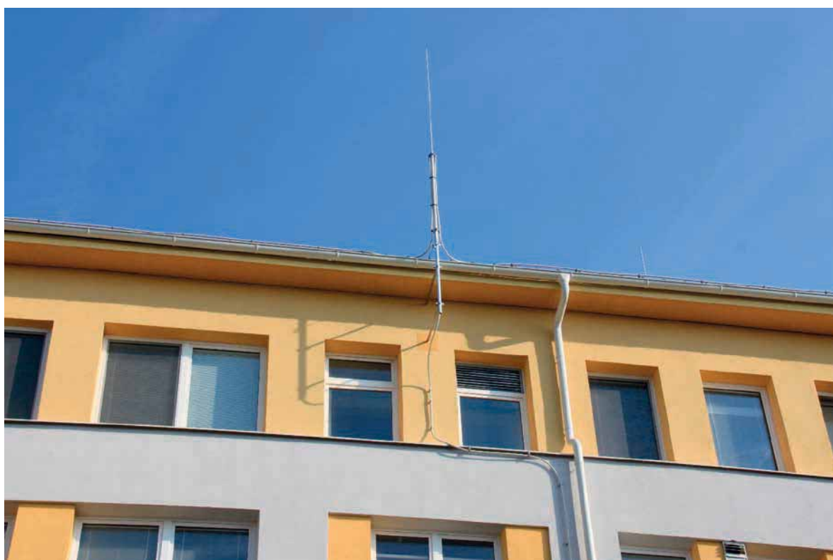
Obrázek 5 – Detail podpůrné trubky s jímačem
