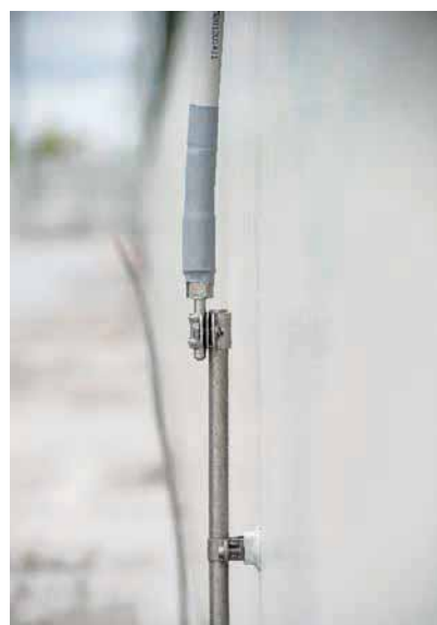
Obr. 8. Provedení připojení na zemnicí soustavu
