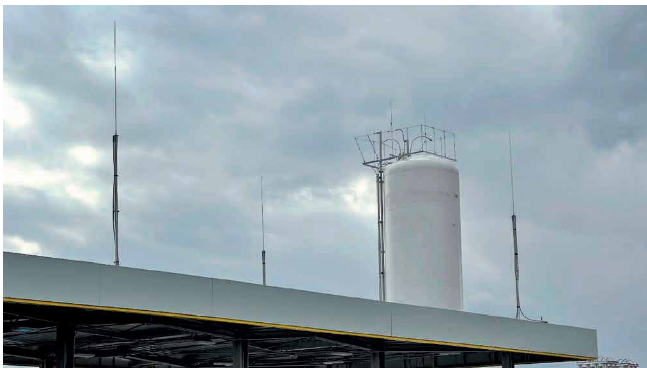
Obrázek 3 – Detail jímací soustavy
