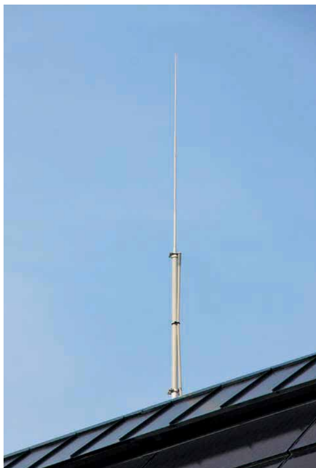
Obrázek 8 – Podpůrná trubka s jímáčem
