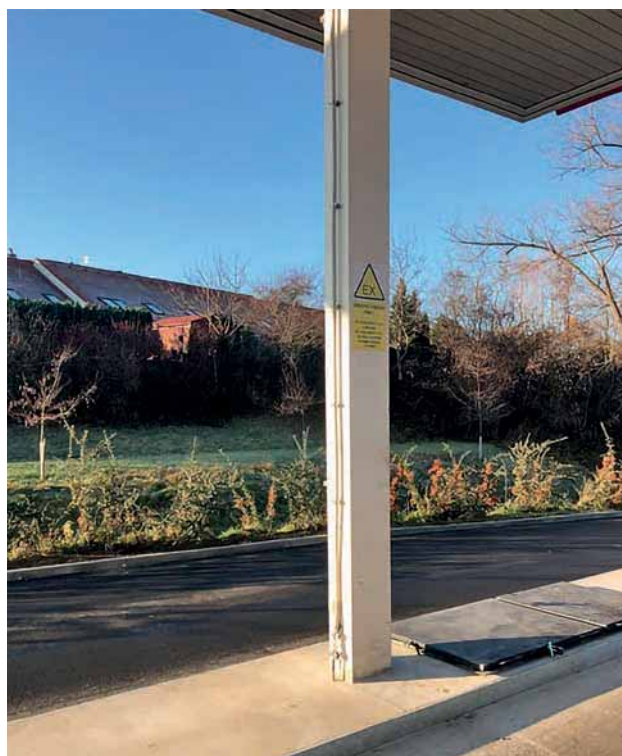
Obrázek 6b – Detail svodů
