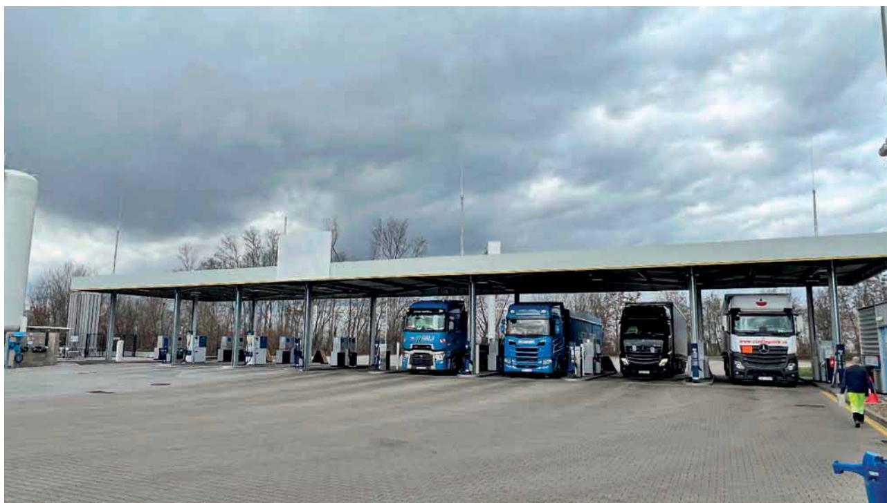
Obrázek 2 – Celkový pohled na čerpací stanici
