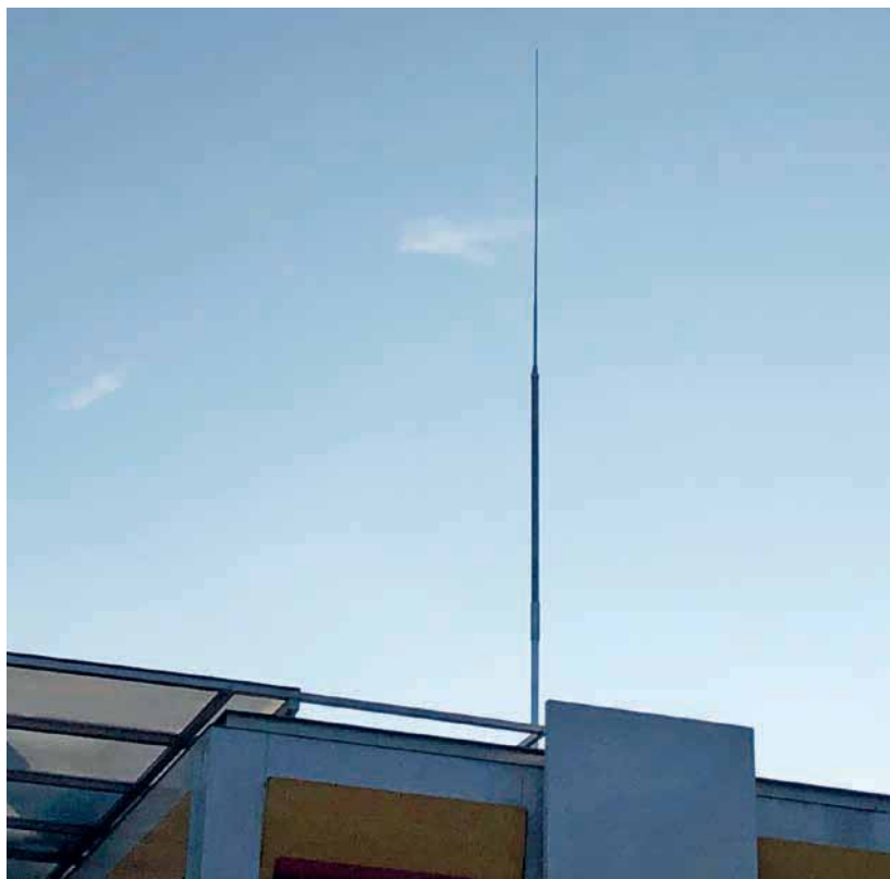
Obrázek 5 – Detail jímáče
