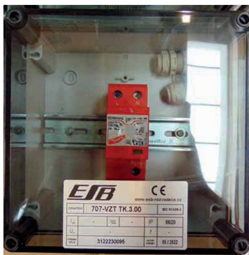
Obr. 6.-7. Rozvodnice s kombinovaným svodičem přepětí DEHNshild TT 255 FM před dodáním na stavbu
