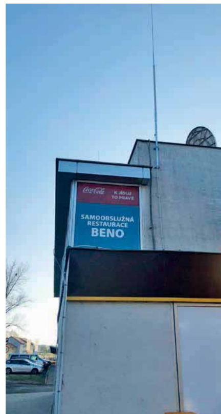
Obrázek 6a – Detail svodů
