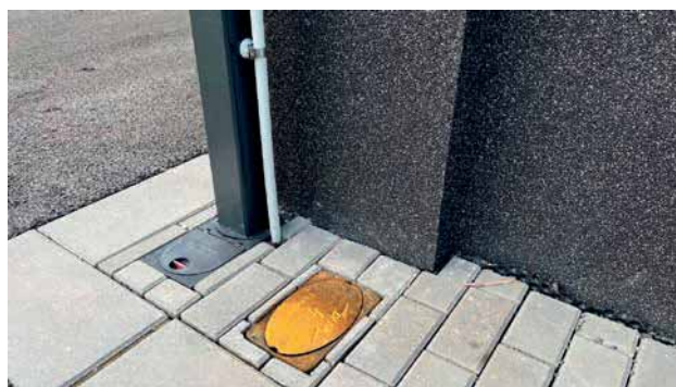
Obr. 5. Svod HVI vodičem do zemní litinové krabice
