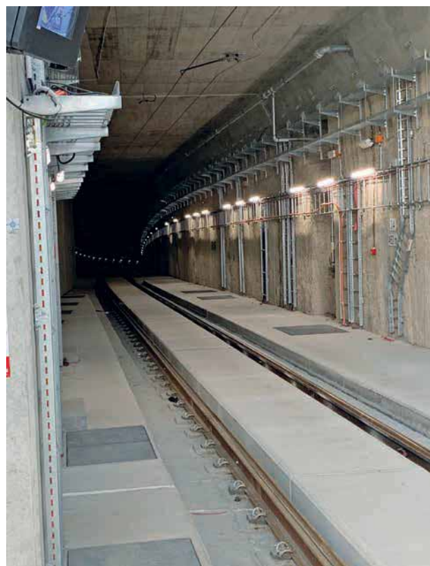
Obr. 3. Západní brána – vjezd do hloubeného tunelu
