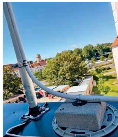
Obr. 6. Detail prostupu podpůrné trubky
