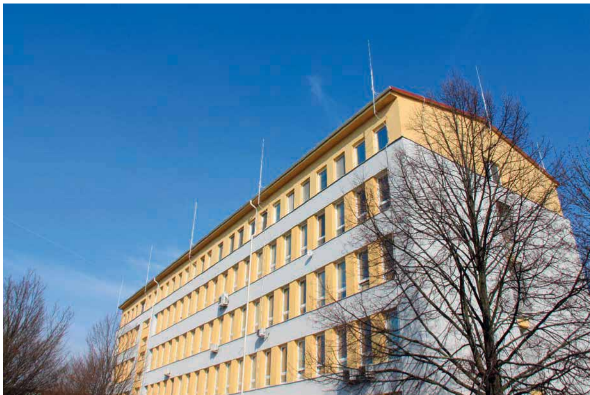
Obrázek 2 – Jižní pohled na Pavilon C
