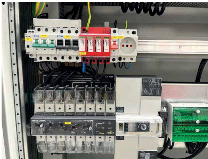
Detail zapojení SPD náhradního zdroje (UPS)
