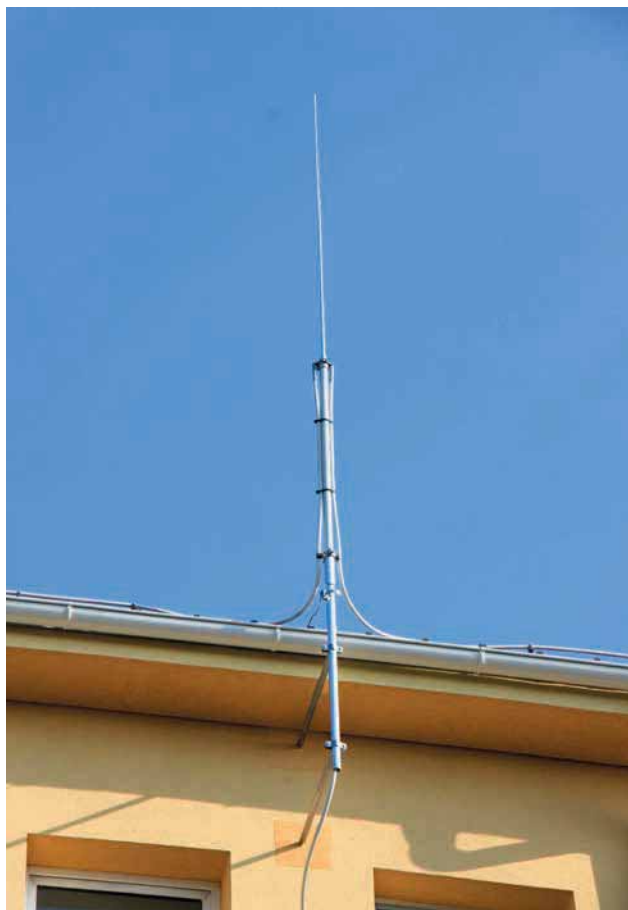
Obrázek 6 – Detail podpůrné trubky s jímačem
