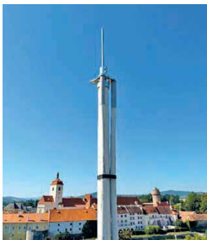
Obr. 7. Napojení vodiče HVI na podpůrnou trubku
