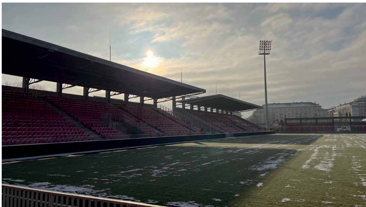
Obr. 5. Pohled na stadion a jímací soustavu
