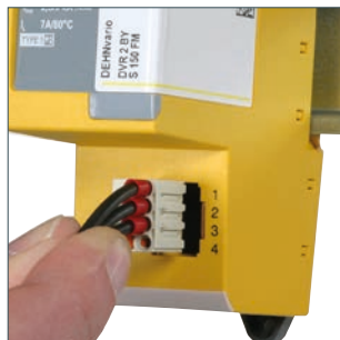
Jednoduché vyjmutí jednotky svorek při výměně svodiče.
