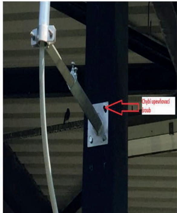
Ukázka chybějícího šroubu – snížená stabilita
