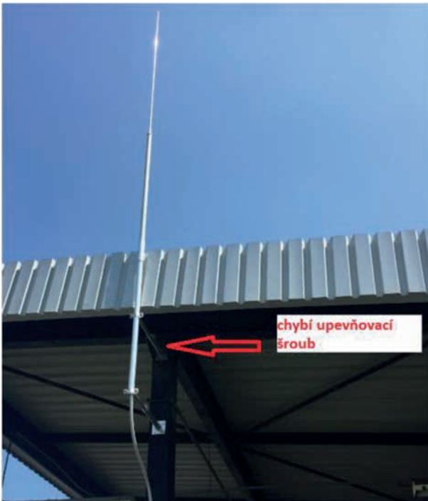
Ukázka chybějícího šroubu – snížená stabilita
