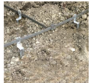
Obvodový zemniční, pásková nerezová ocel, NIRO V4
