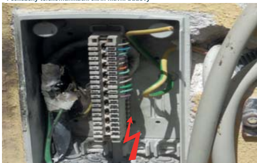
Poškozený telekomunikační skříň hlavní budovy
