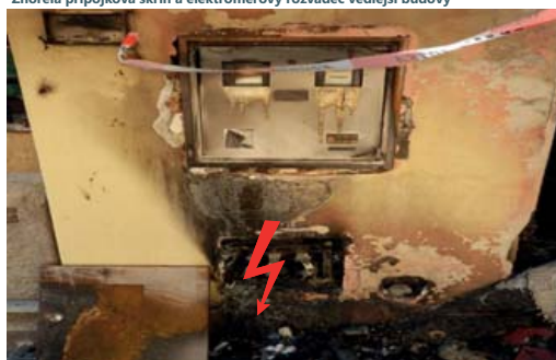
Zhořelá přípojková skříň a elektroměrový rozváděč vedlejší budovy
