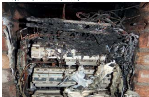
Zhořelý podružný rozváděč vedlejší budovy
