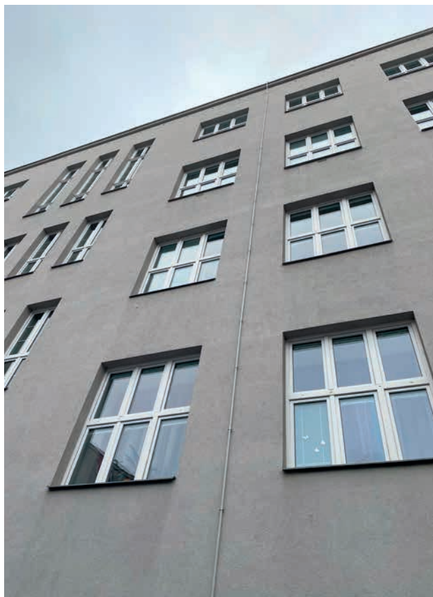
Instalace svodu pomocí vodiče HVI
