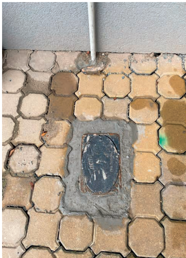
Detail svodu a litinové zemní krabice
