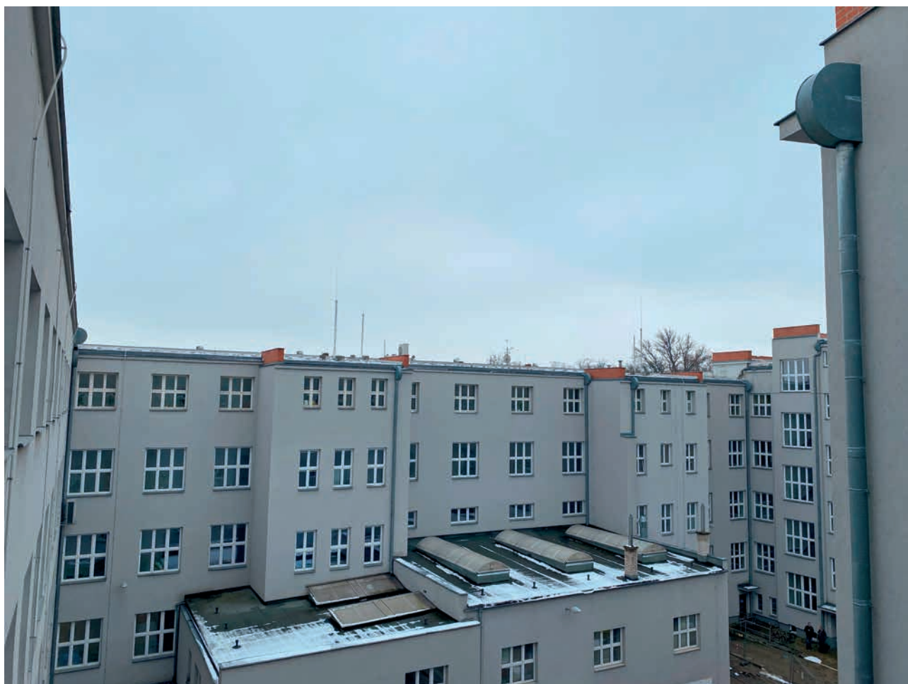
Pohled na nádvoří
