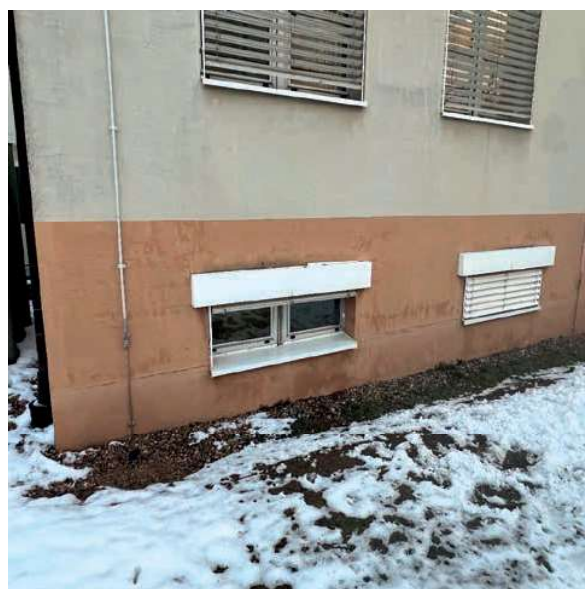
Detail umístění svodu na stěně objektu
